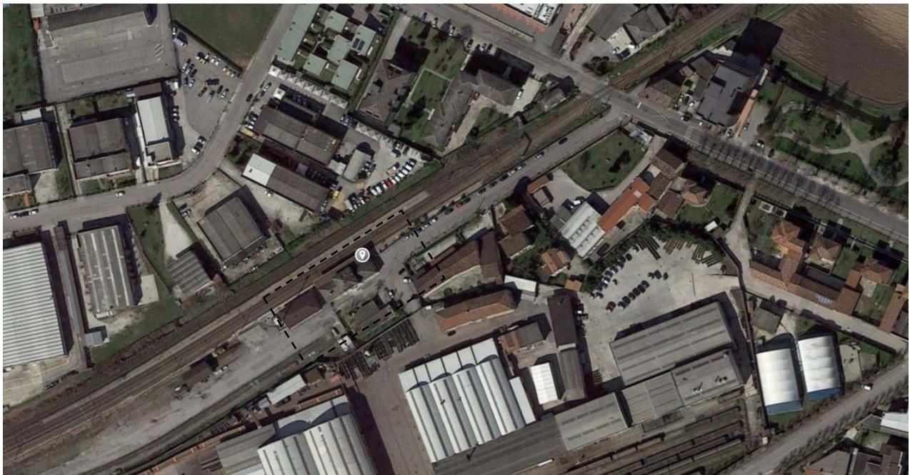
Figura 1.2 - Localizzazione della stazione di Castellucchio.
