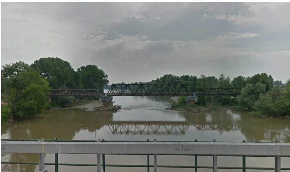
Figura 2 – Attraversamento ferroviario esistente sul Fiume Oglio.
