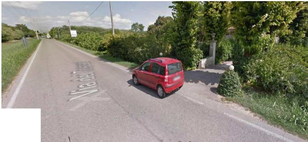
Vista da via dei Toscani dell'accesso da garantire in fase di cantiere e da riposizionare rispetto alla configurazione di progetto
