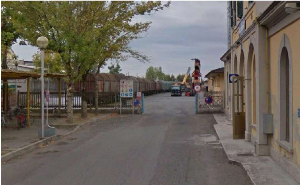
Foto1 - Vista del cantiere 3.AT.07 dal piazzale di stazione
