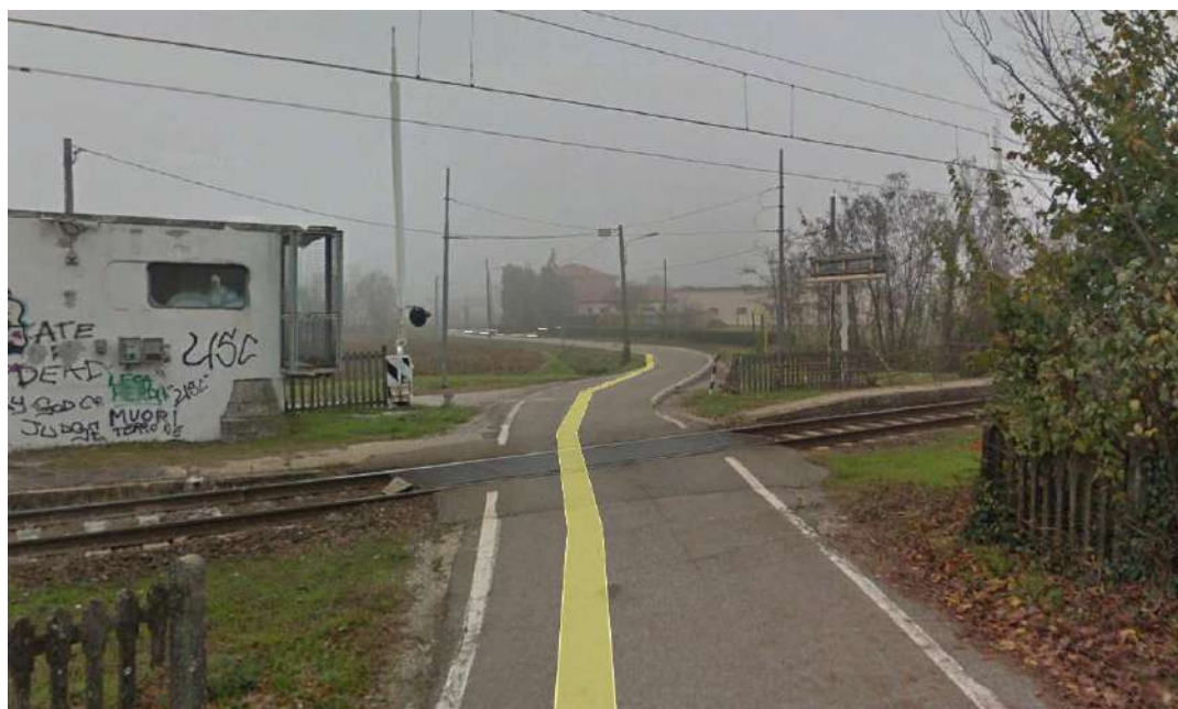
Vista del PL da sopprimere su Strada Campo Brondino
