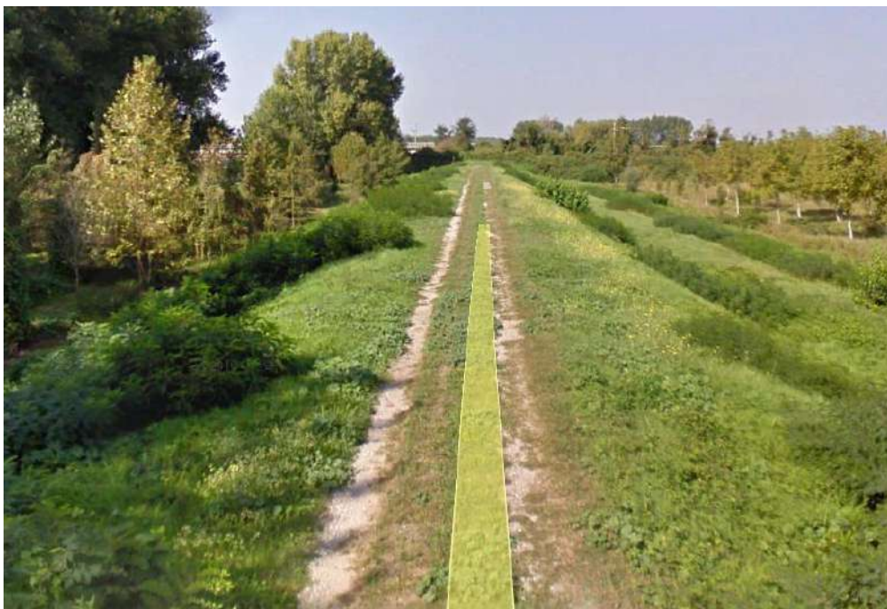
Vista della viabilità arginale in sx idraulica di accesso al cantiere
