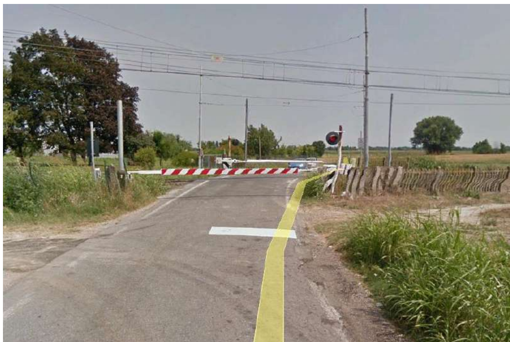
Vista del PL attuale sulla SP55 al km 79+634
