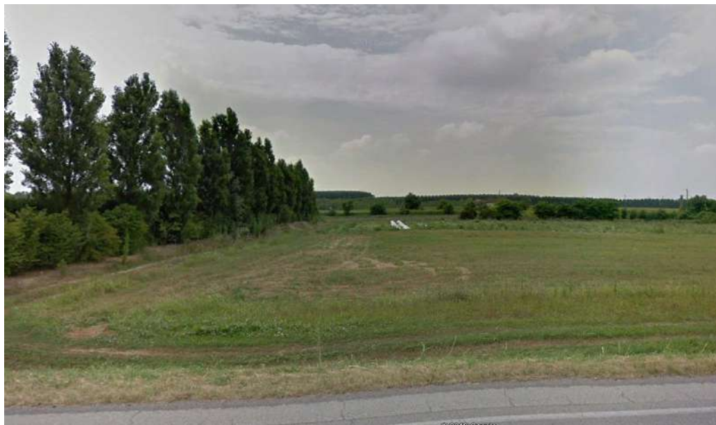
Foto1 - Vista del cantiere AS.14 (google street view)
