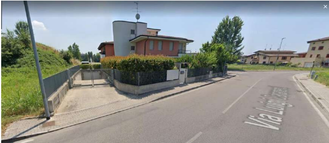
Vista da via L. Caranenti della rampa esistente da (sul lato sud della ferrovia)
