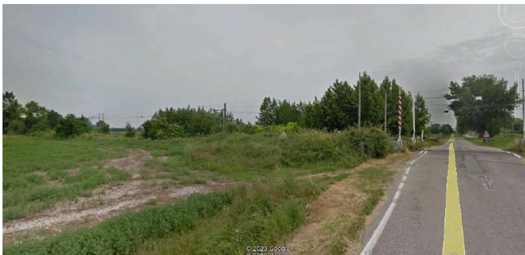
Vista del PL da sopprimere sulla SP31 (fonte google street view)
