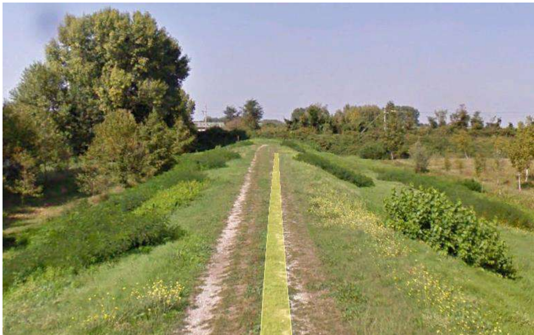
Vista della viabilità di accesso al cantiere 3.CO.05 (fonte google street view)
