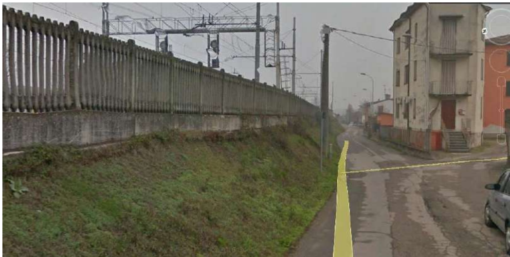
Vista di via Borgo Fornace interessata dalla realizzazione della barriera antirumore lungo la linea
