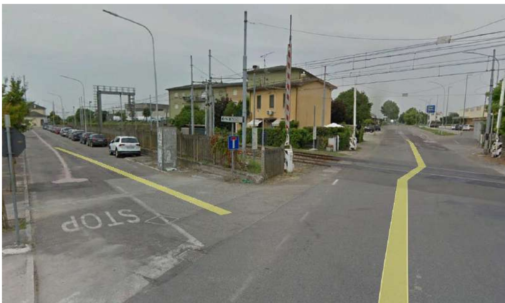
Vista della viabilità di accesso al cantiere (Via Caix) dalla SP78, PL con linea esistente da sopprimere
