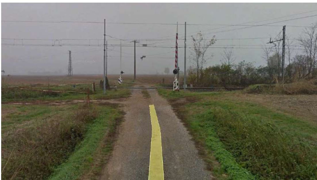
Vista della viabilità di accesso al cantiere e PL da sopprimere (fonte Google Street View)
