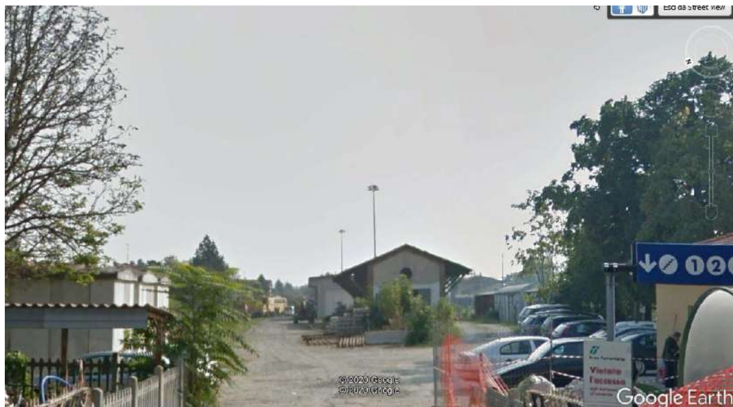
Foto1 – vista del cantiere 3.AR.01 (fonte google street view)
