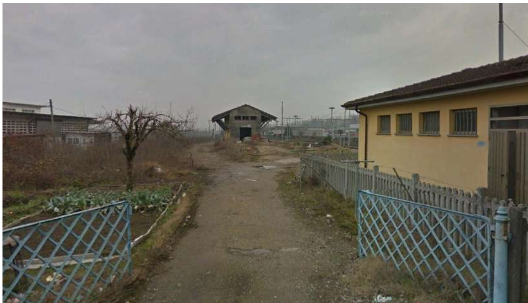
Foto 1 - Vista dell'area di cantiere 3.AT.13 (fonte Google Street View)
