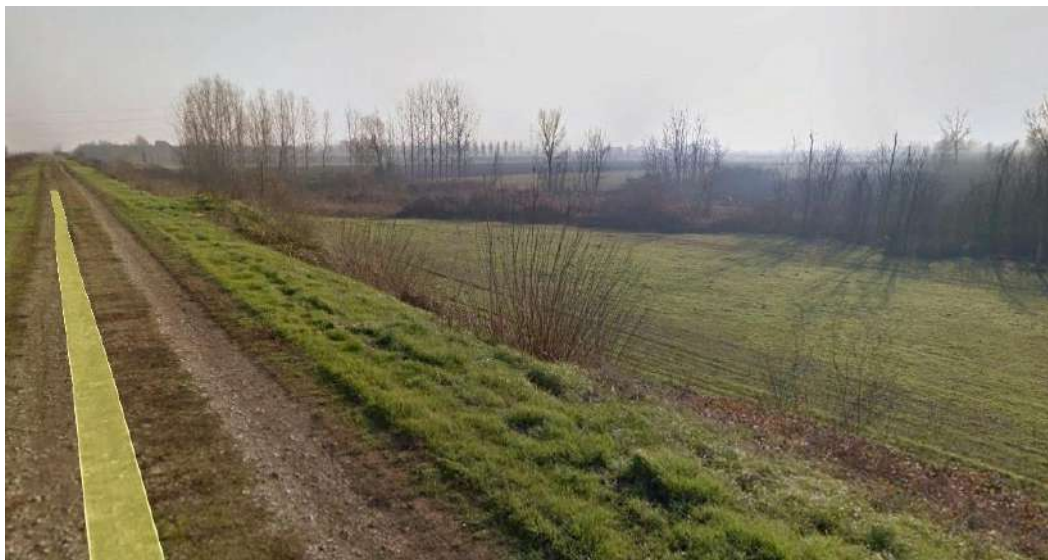
Foto1 - Vista del cantiere 3.AS.12 (google street view)
