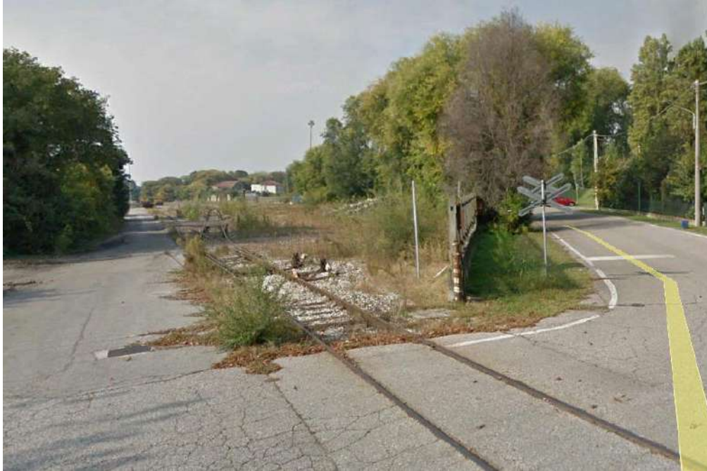
Foto 1 – vista del cantiere 3.AR.05 e della pista di accesso da via L.Martini (fonte google street view)
