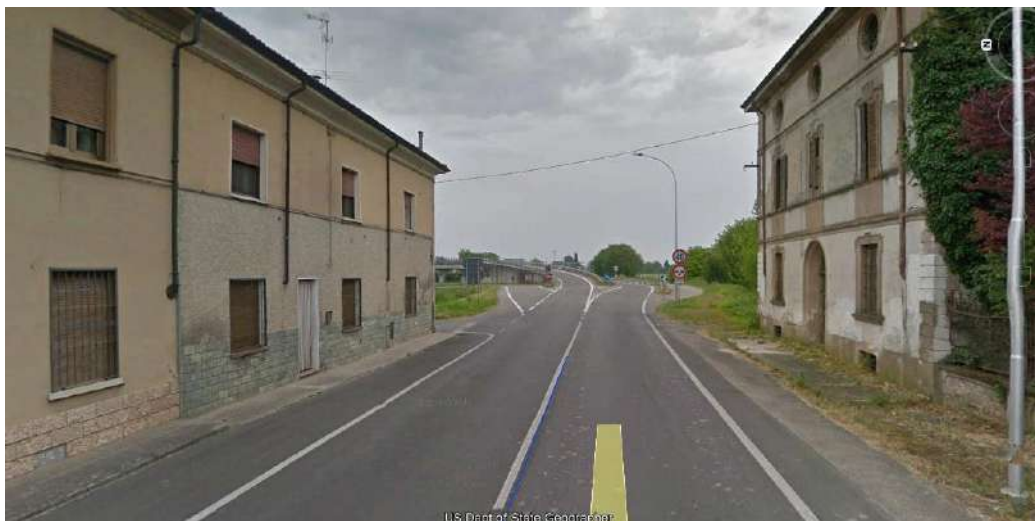
Vista degli accessi interferiti dalle attività lavorative su via del Popolo
