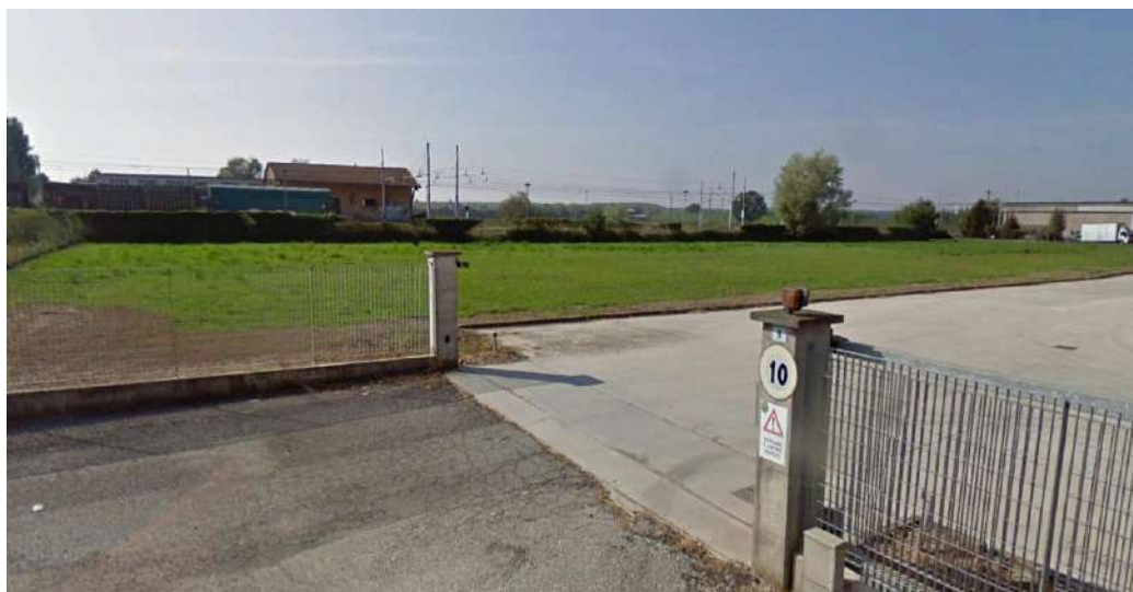
Foto1 - Vista del cantiere AS.16 (google street view)
