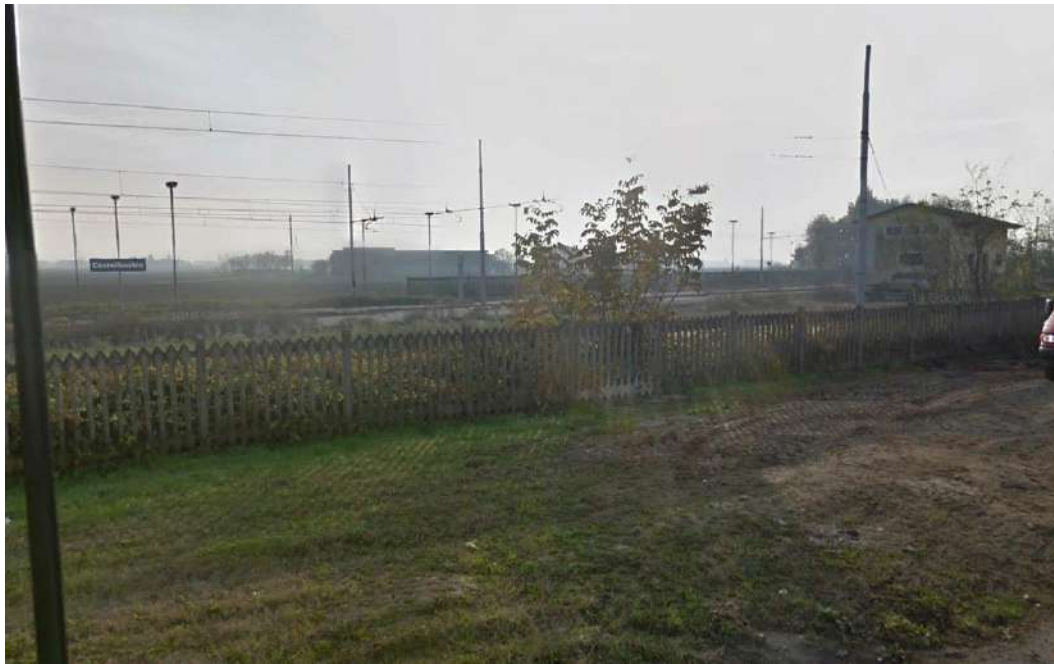
Foto 1 – vista del cantiere 3.AR.04 da via Monesi
