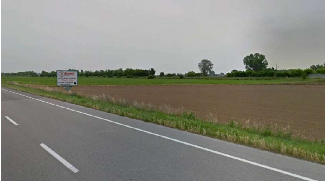
Foto1 - Vista del cantiere 3.CB.01 (fonte google street view)
