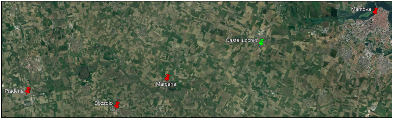
Figura 3 - Stato attuale area oggetto di intervento
