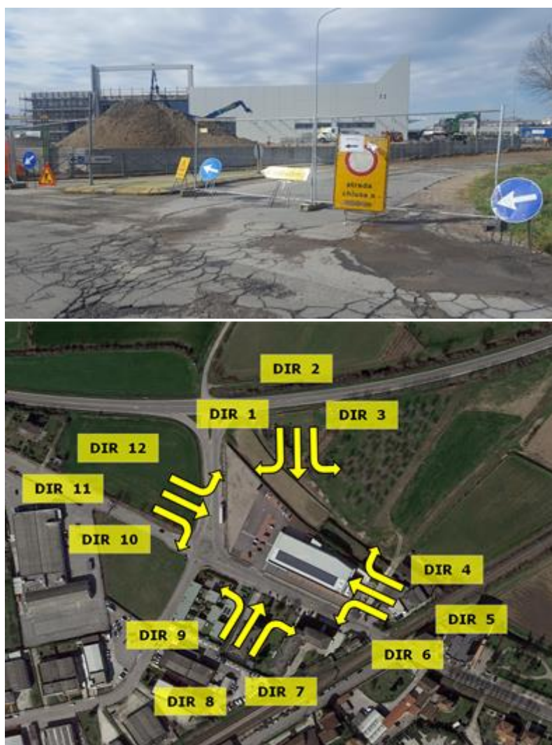
Figura 73. Chiusura Via Cremona Ovest per lavori
