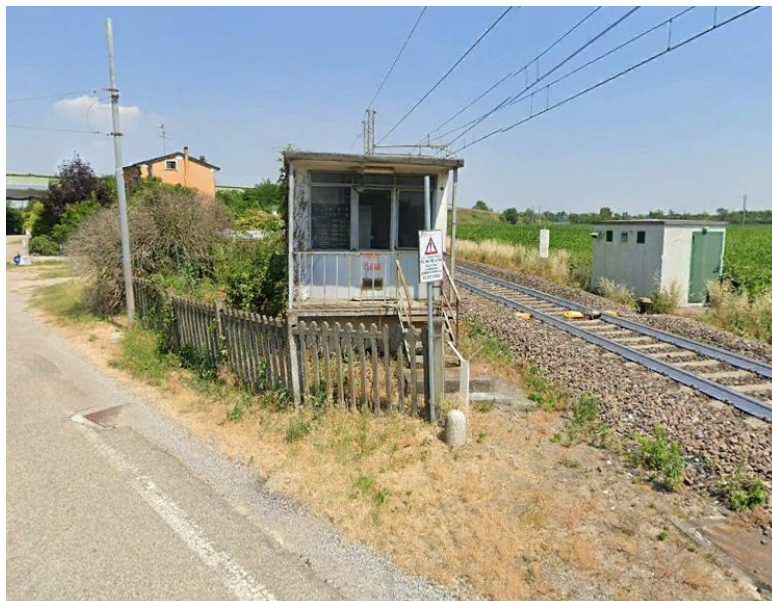
Figura 41: foto stato di fatto
