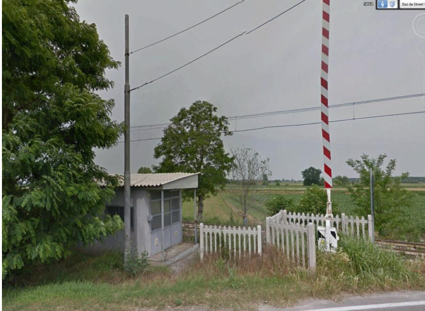
Figura 17: foto stato di fatto D10
