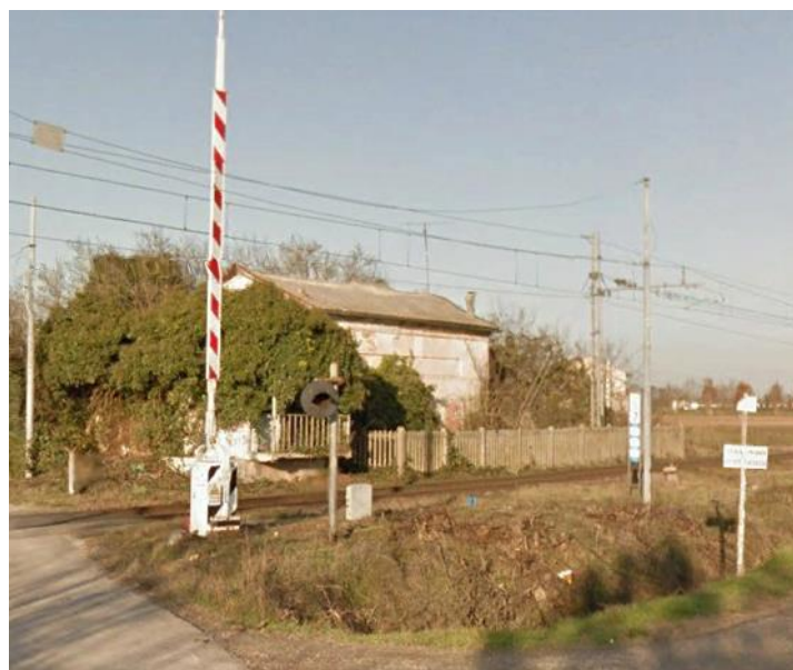
Figura 28: foto stato di fatto
