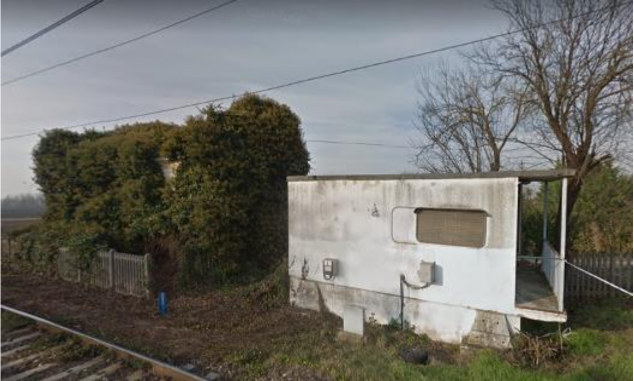
Figura 33: foto stato di fatto
