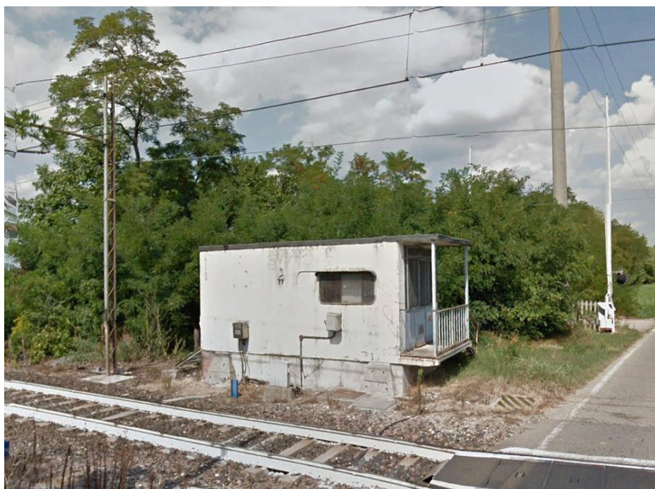
Figura 39: foto stato di fatto
