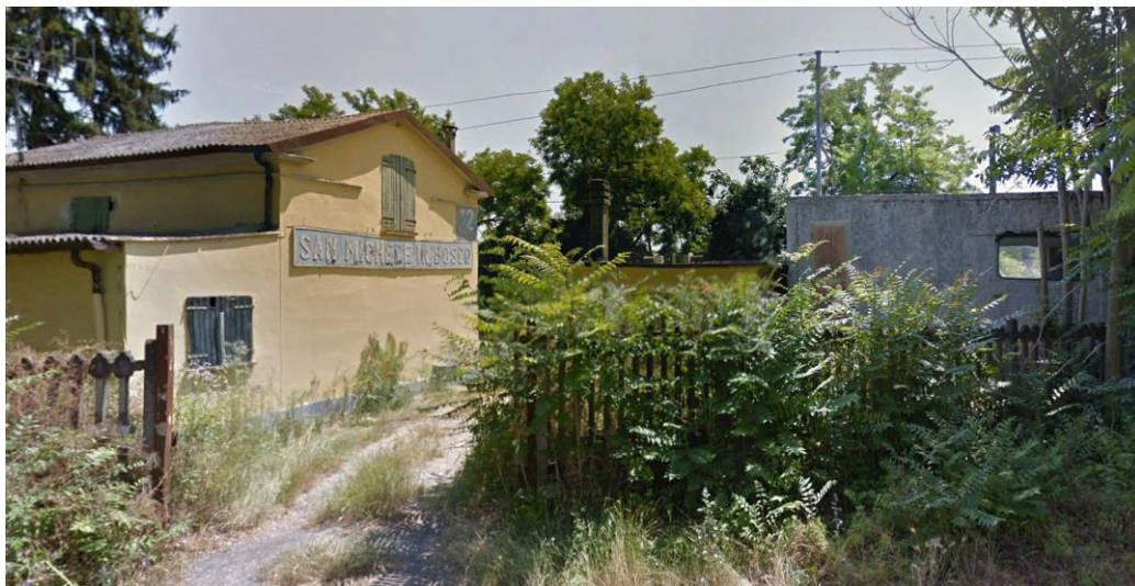
Figura 24: foto stato di fatto
