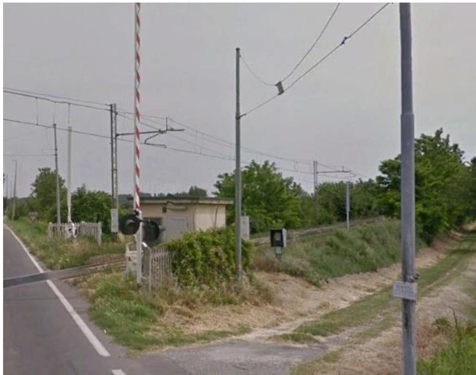
Figura 18: foto stato di fatto D11
