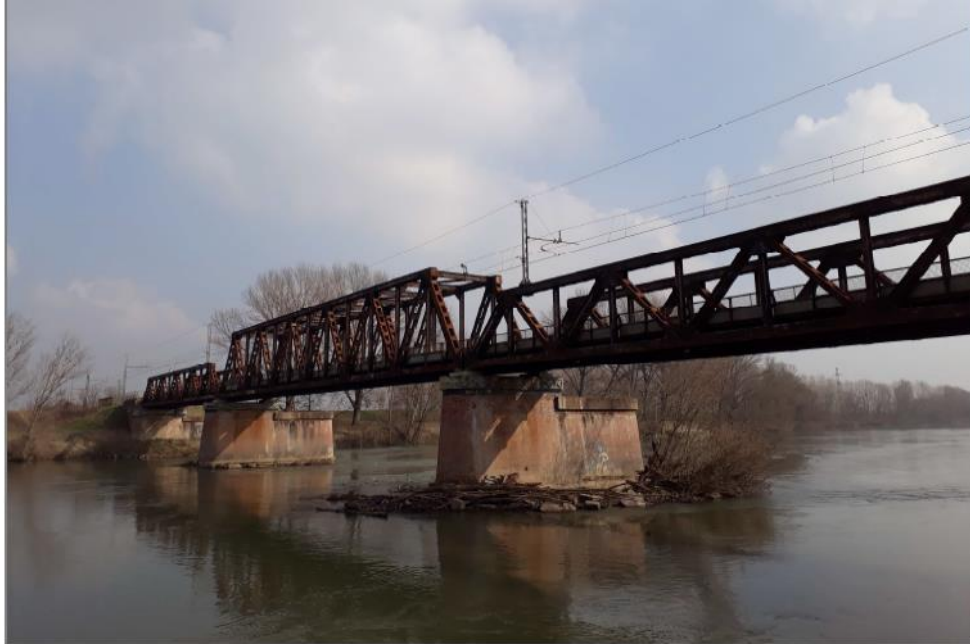
Figura 5: Ponte esistente sul Fiume Oglio: foto configurazione attuale con vista da monte verso valle - zona interessata dalla realizzazione del nuovo attraversamento - Fonte: sopralluogo ITALFERR del 19/02/2020
