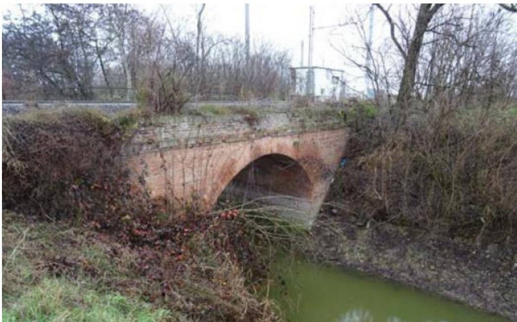
Figura 9: Foto stato di fatto
