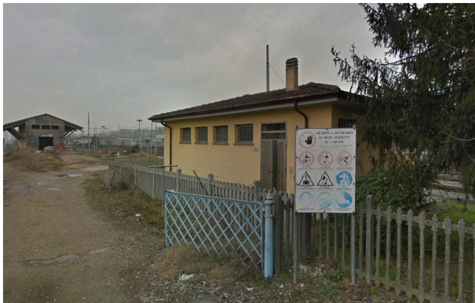
Figura 20: foto stato di fatto
