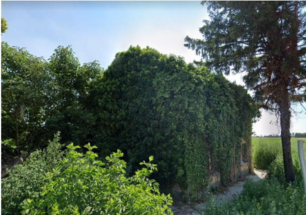
Figura 36: foto stato di fatto
