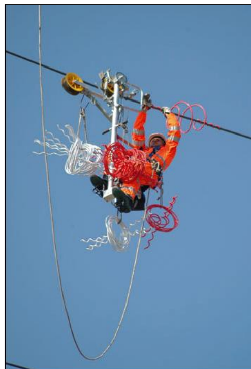
Montaggio spirali
