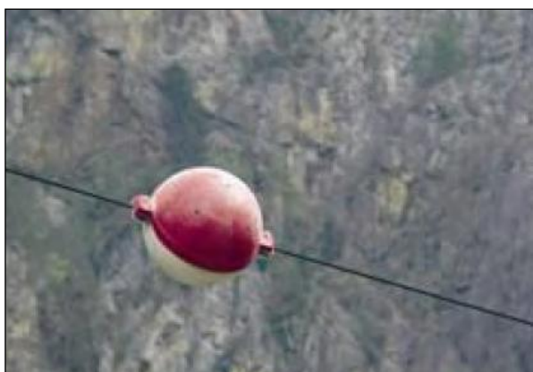
Sfera di poliuretano colorata e Spirale: immagini di dettaglio
