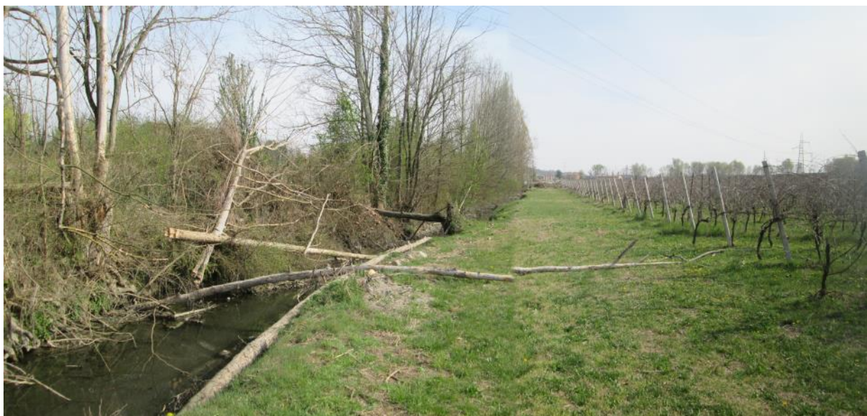
Foto 7: vista verso sud dell'area nella quale sorgerà il viadotto Tionello
