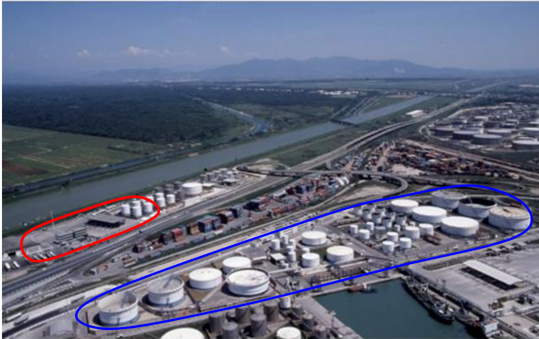
Figura 1: Vista aerea Deposito Doganale (perimetro azzurro) e del Deposito Nazionale (perimetro rosso)
