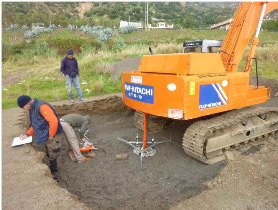
Figura 28: Prove di carico eseguite presso l'area di progetto.
