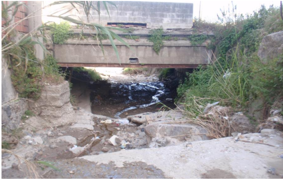
Figura 22: passaggio della S.S. con salto di fondo in primo piano
