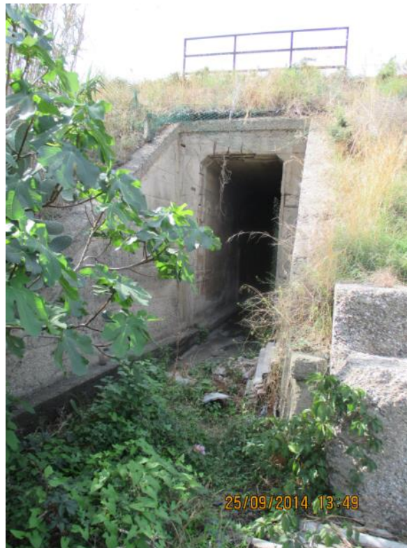
Figura 26: il passaggio del rilevato ferroviario
