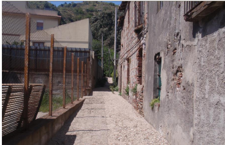
Figura 11: caratteristiche del tratto 3 del torrente Farota
