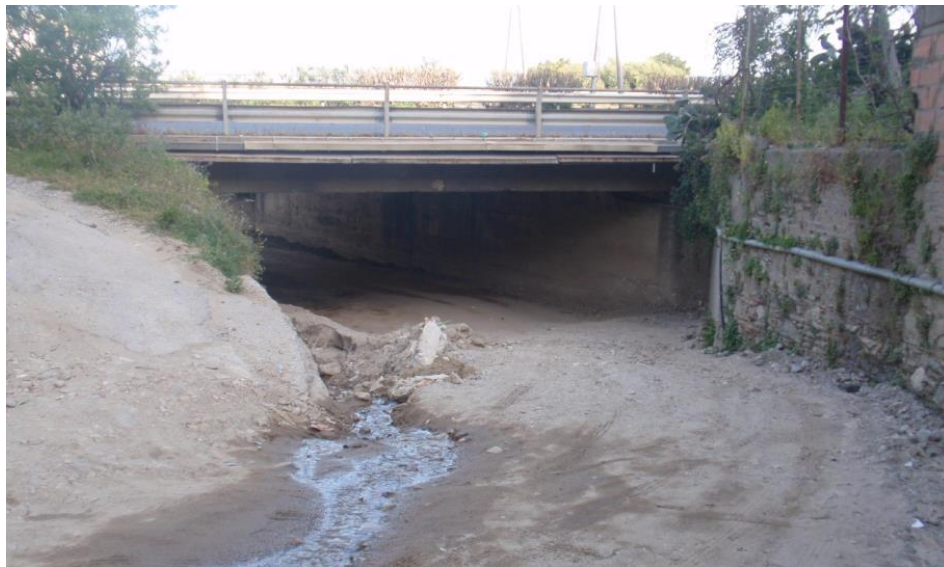
Figura 20: attraversamento autostradale visto da monte
