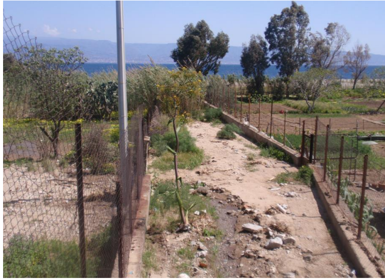
Figura 14: tratto a valle del rilevato della ferrovia.
