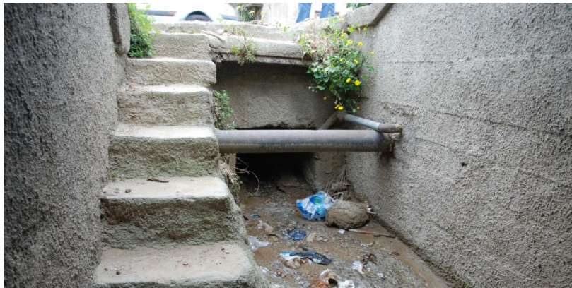
Figura 12: attraversamento strada statale
