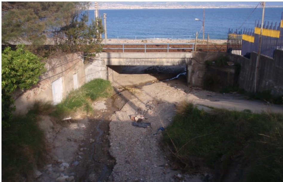
Figura 23: attraversamento della linea ferroviaria
