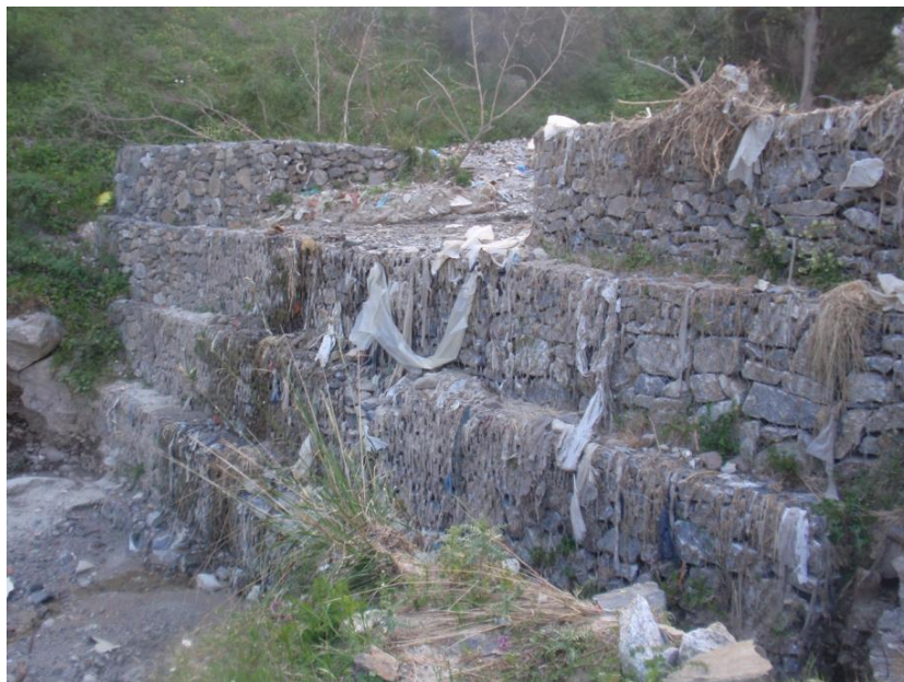
Figura 17: una delle briglie a gabbioni esistenti nel tratto superiore del Guidari
