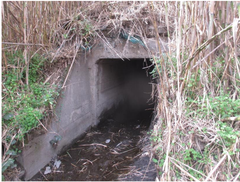
Figura 29: scolo minore a Nord – attraversamento FS e sbocco a mare
