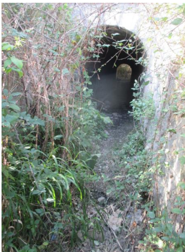
Figura 31: scolo minore a Sud – attraversamento FS e sbocco a mare
