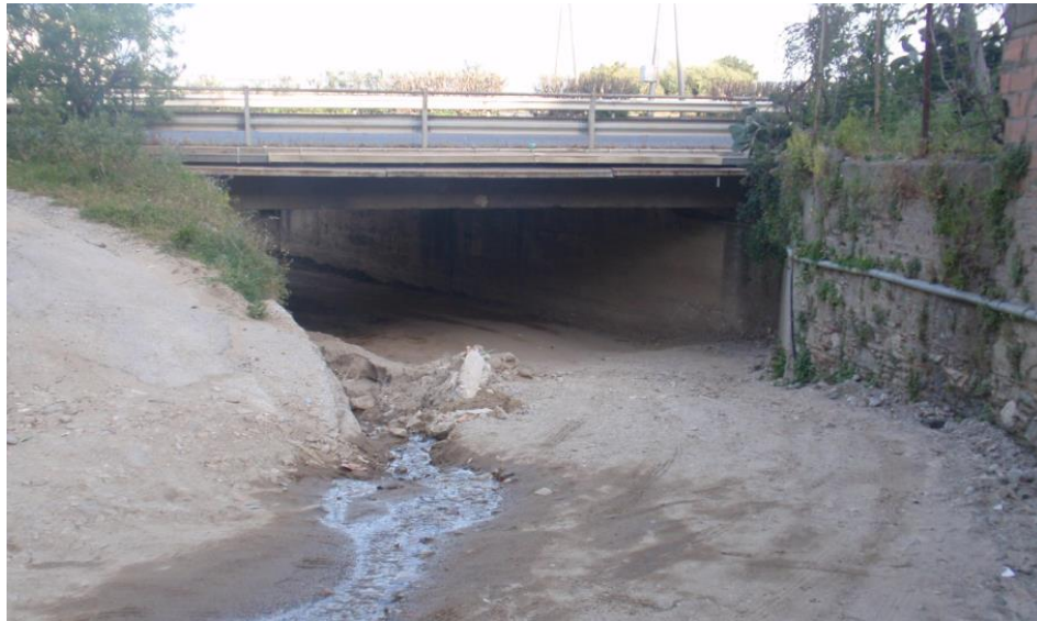
Figura 20: attraversamento autostradale visto da monte
