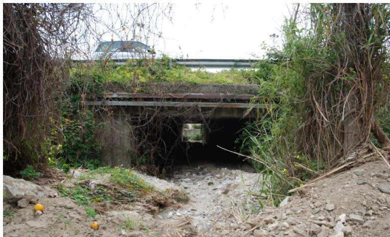
Figura 10: tratto 2 – manufatto di attraversamento autostradale
