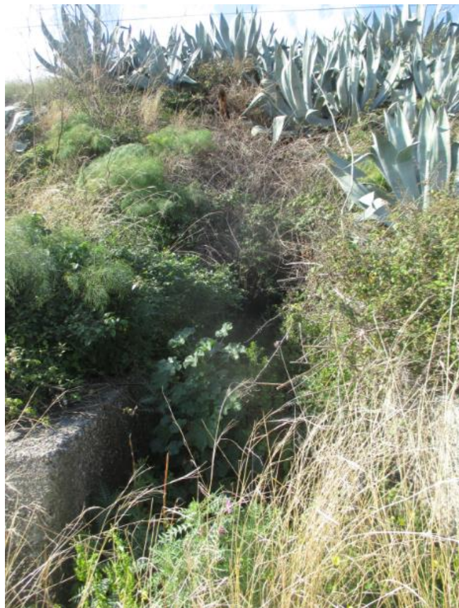
Figura 30: scolo minore intermedio – attraversamento FS e sbocco a mare
