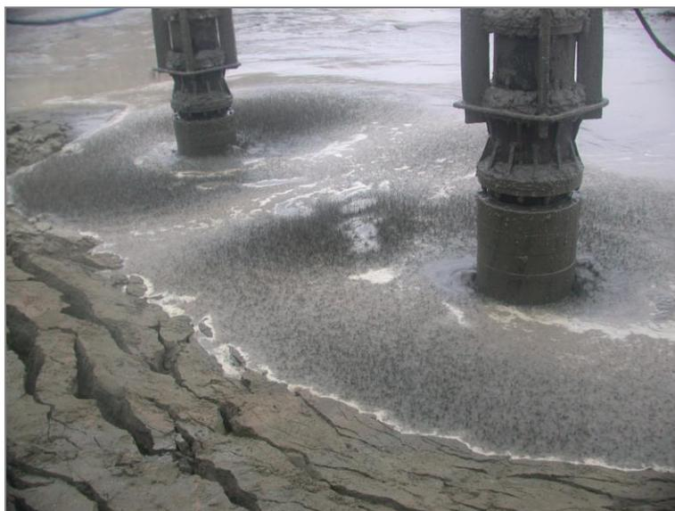
Figura 55 – Particolare delle sonde introdotte nel terreno.
