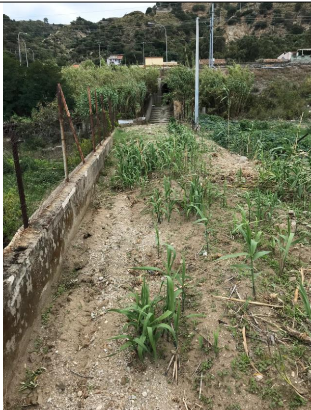
Figura 15 - sbocco del torrente costituito da una scala di collegamento
