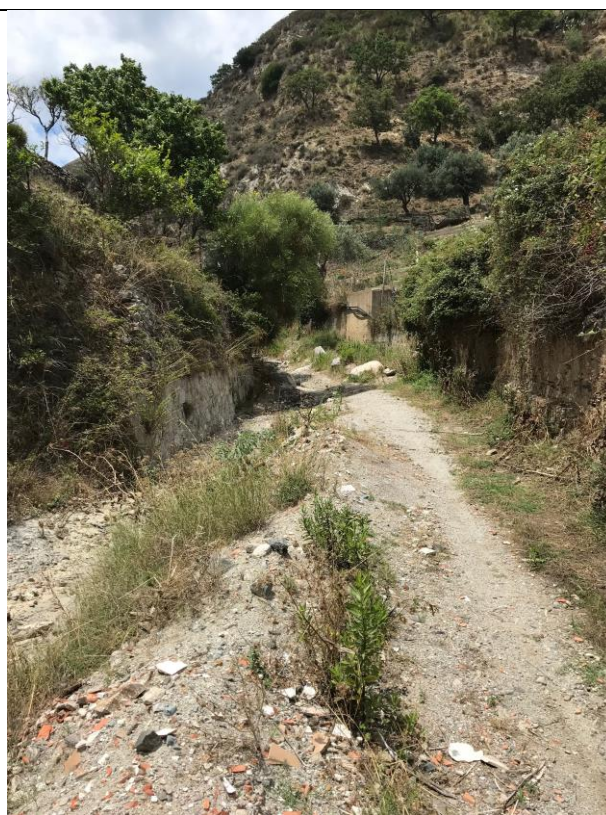
Figura 25 - vista del torrente, strada sulla destra e cumulo di rifiuti misti da demolizione abbandonati lungo l'argine
