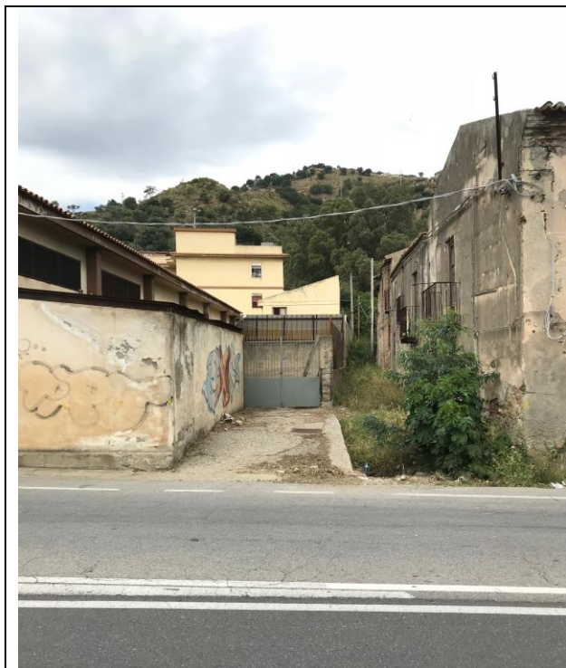
Figura 17 - porzione centrale del torrente non raggiungibile
