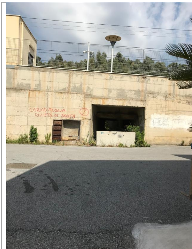
Figura 8 - inizio tombatura torrente nella porzione centrale, sotto la ferrovia
