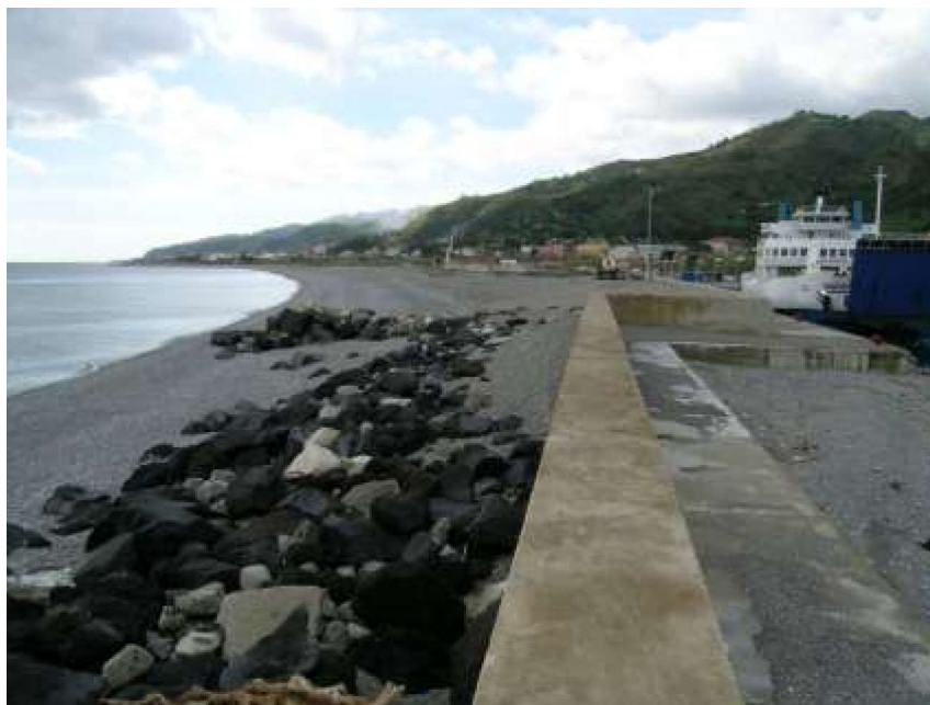
Foto 1 – L’area interessata dall’intervento vista dalla testata della Darsena esistente
