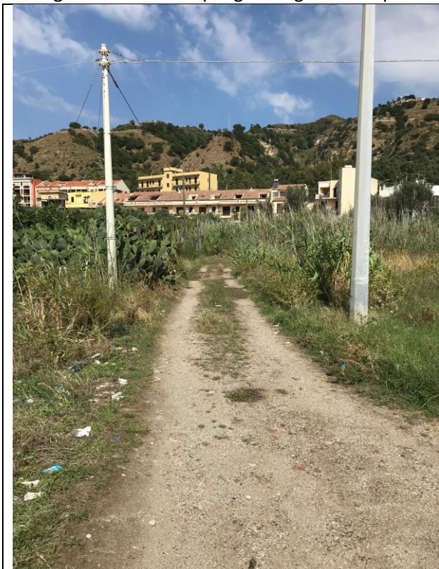
Figura 6 - strada di accesso e porzione finale del torrente Canneto, notare i rifiuti ai lati dell'"alveo"
