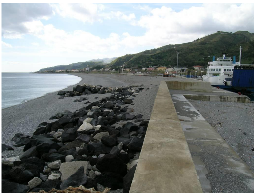
Foto 1 – L’area interessata dall’intervento vista dalla testata della Darsena esistente
