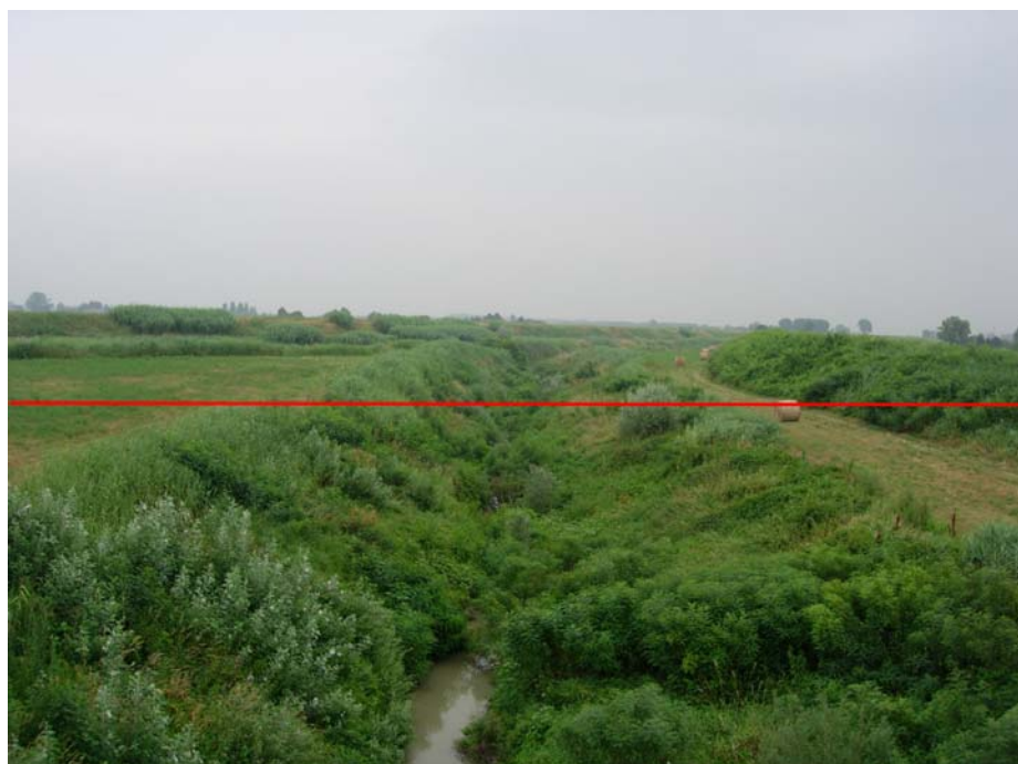
Foto 2.17/D: Panoramica della sezione di attraversamento del T. Idice, che sarà superato in subalveo per mezzo di un microtunnel
