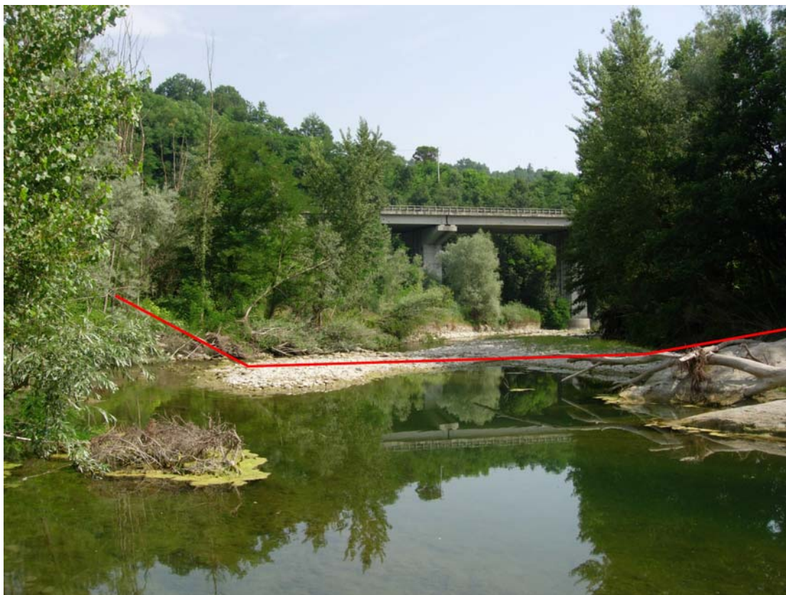
Foto 2.1/D: Panoramica dell'attraversamento del F. Savio
