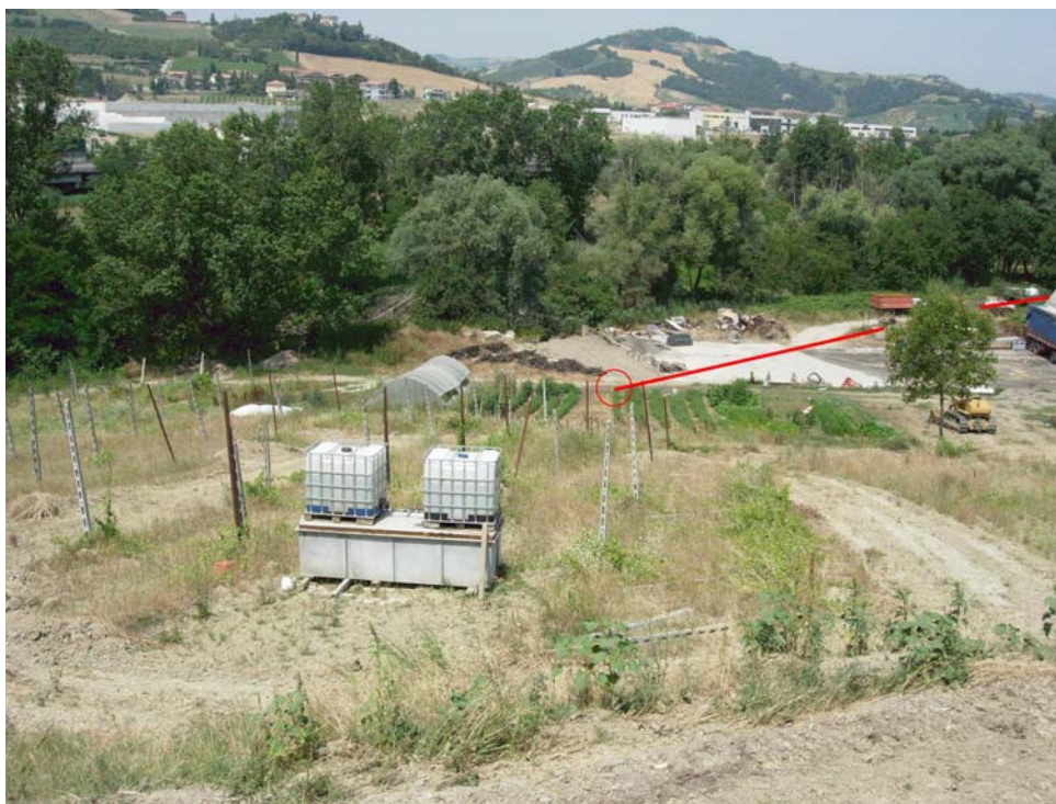
Foto 2.6/B: Area di imbocco nord del microtunnel in località "Bantone di Sotto"
