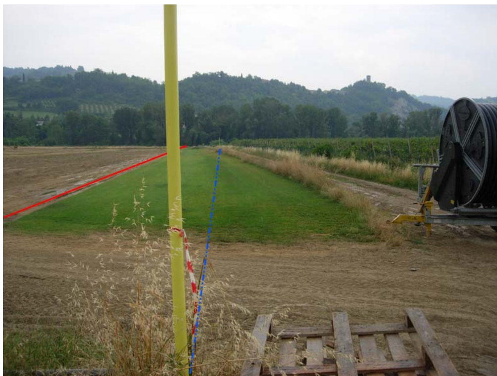
Foto 2.9/A: Panoramica da Via Palazzona verso sud della variante in stretto parallelismo alla condotta esistente (linea blu tratteggiata)
