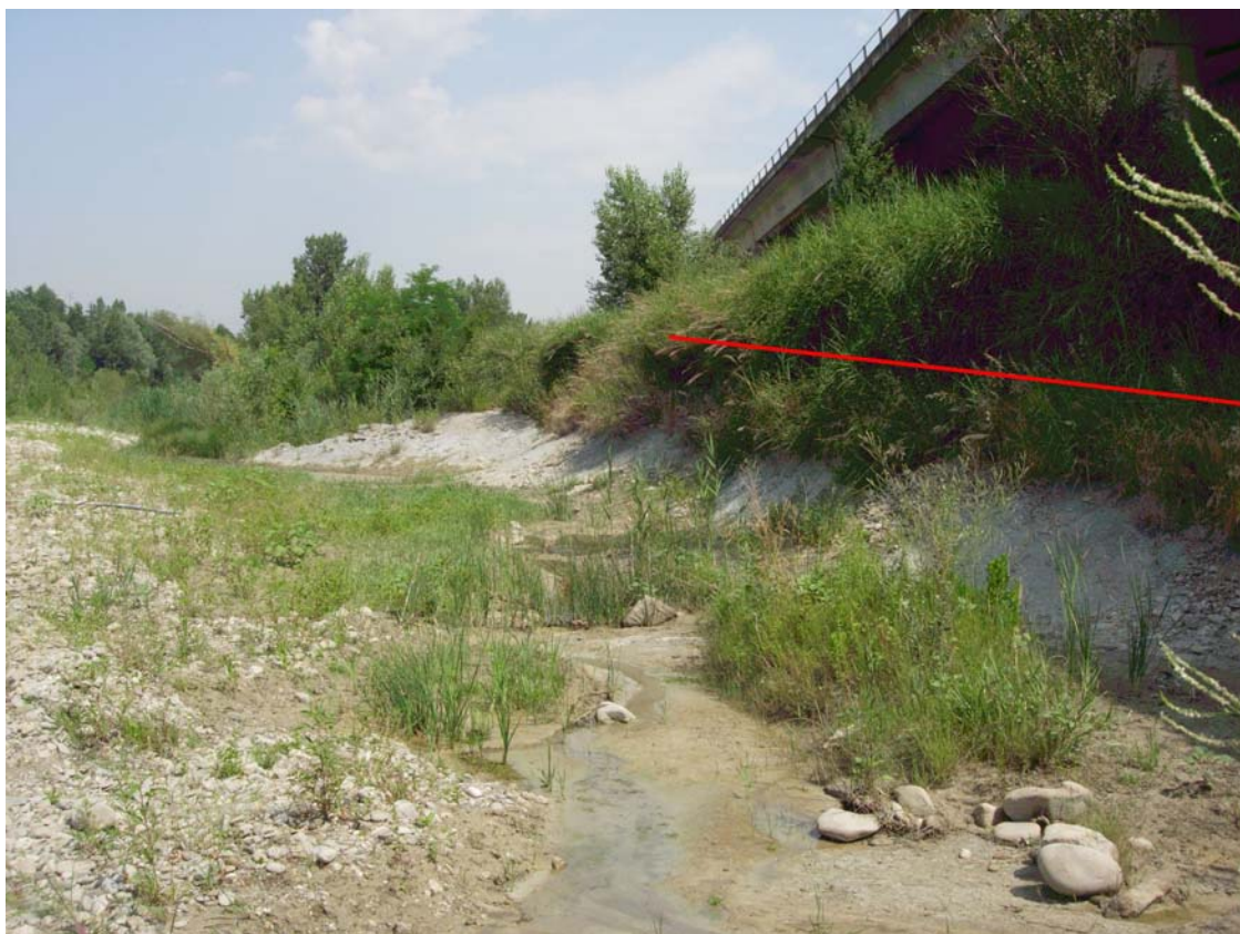
Foto 3.1/A: Tratto di percorrenza dell'alveo del F. Savio in prossimità della frazione Bivio Montegelli (vista in direzione del flusso del gas)
