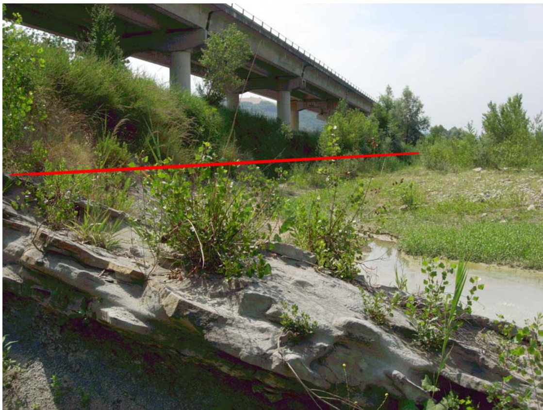
Foto 3.1/B: Tratto di percorrenza dell'alveo del F. Savio in prossimità della frazione Bivio Montegelli (vista in direzione opposta al flusso del gas)
