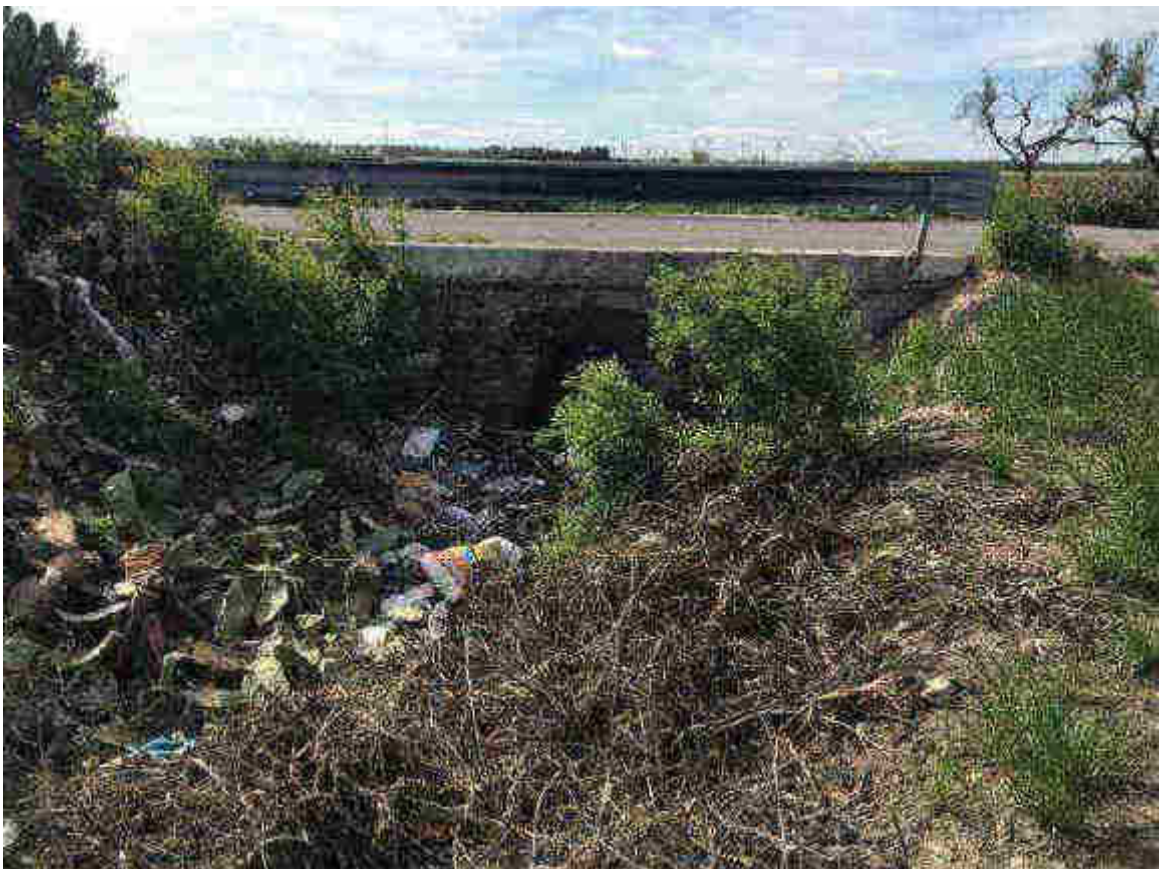
Foto a valle del ponte RS = 703.5
