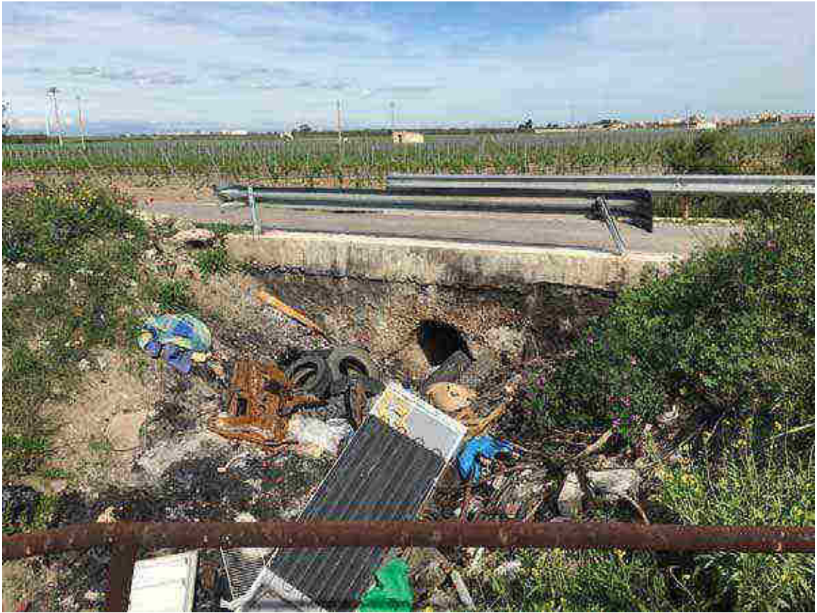
Foto a monte del ponte RS = 703.5
