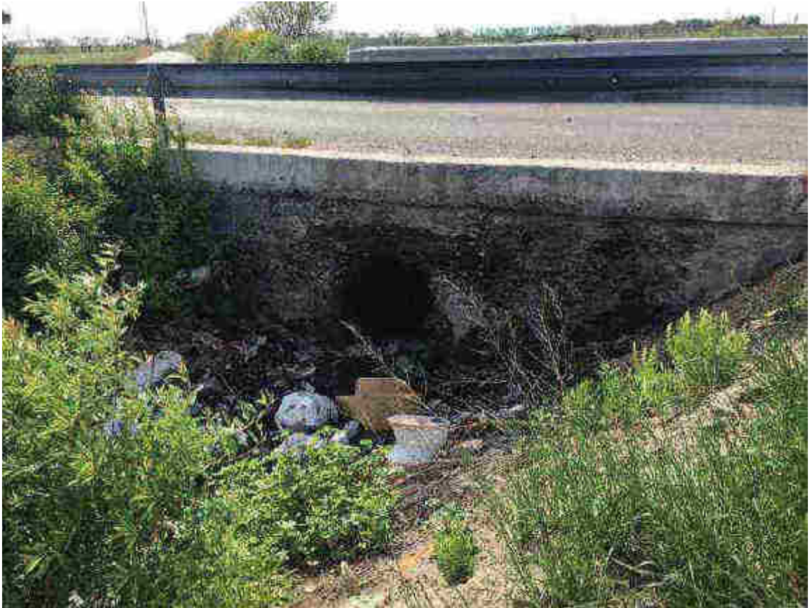
Foto a valle del ponte RS = 703.5
