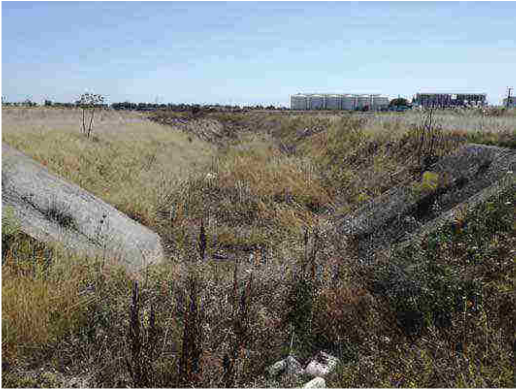
Foto a valle del ponte (HEC-RAS - RS = 233)
