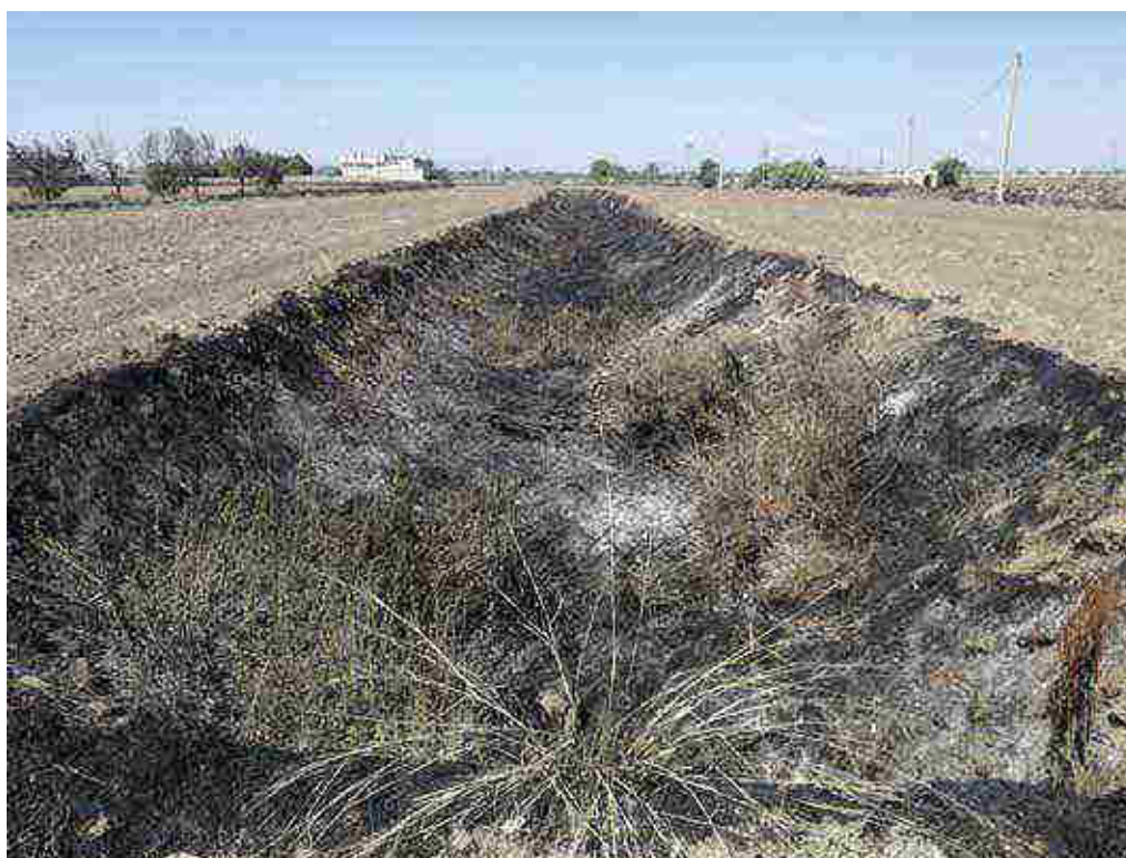
Foto a monte del canale tombato (HEC-RAS - RS = 3141)
