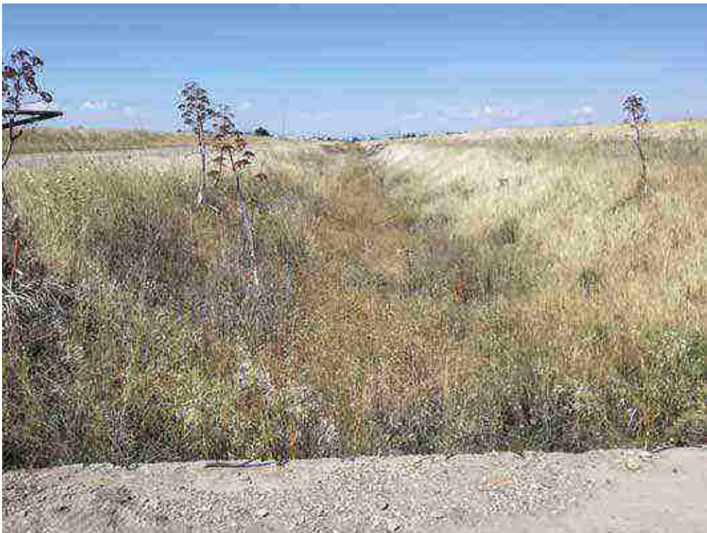
Foto a monte del ponte (HEC-RAS - RS = 233)
