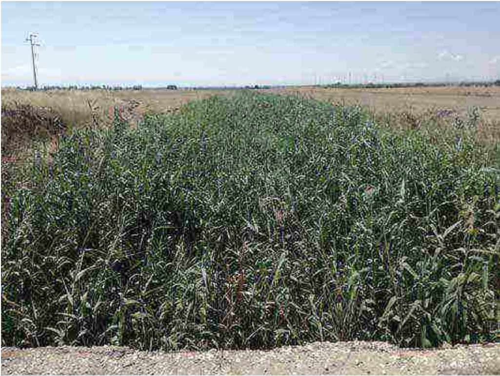
Foto a valle del ponte (HEC-RAS - RS = 850)
