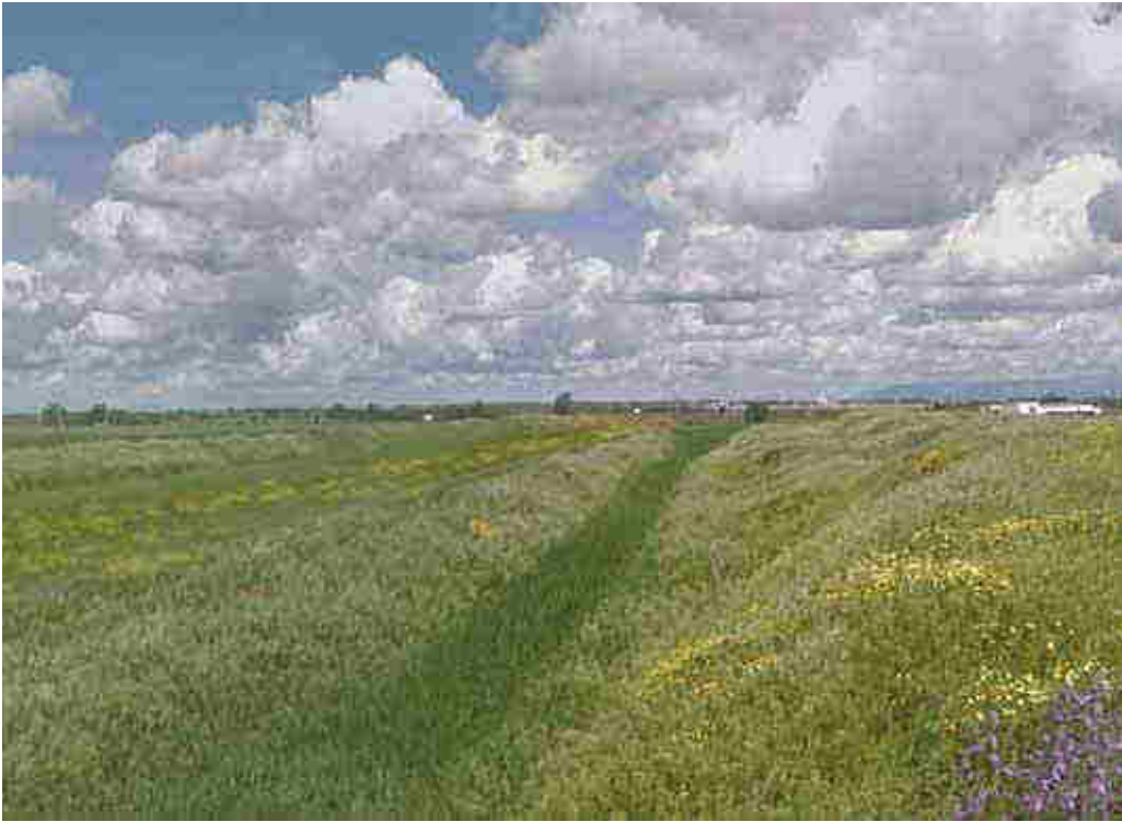
Foto a valle del ponte (HEC-RAS - RS = 400)
