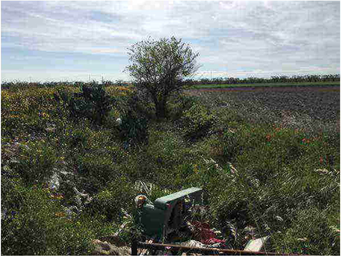
Foto a monte del ponte RS = 720
