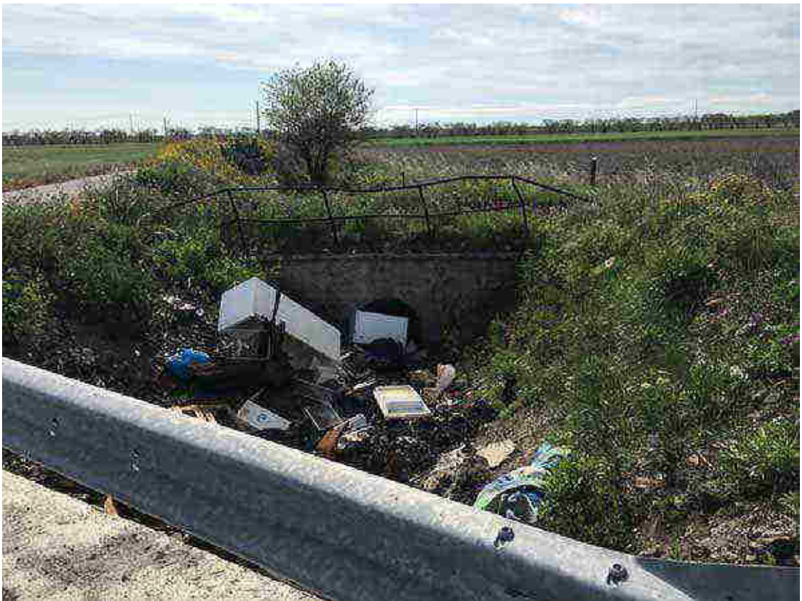
Foto a valle del ponte RS = 720
