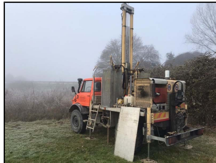
Foto n.41: Esecuzione prova CPTU7
