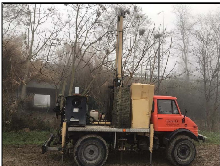
Foto n.40: Esecuzione prova CPTU6
