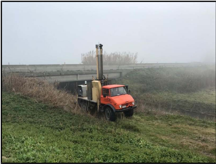
Foto n.43: Esecuzione prova CPTU9
