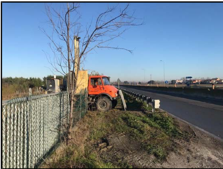
Foto n.36: Esecuzione prova CPTU2
