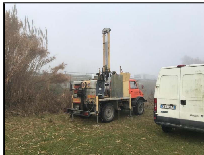
Foto n.42: Esecuzione prova CPTU8
