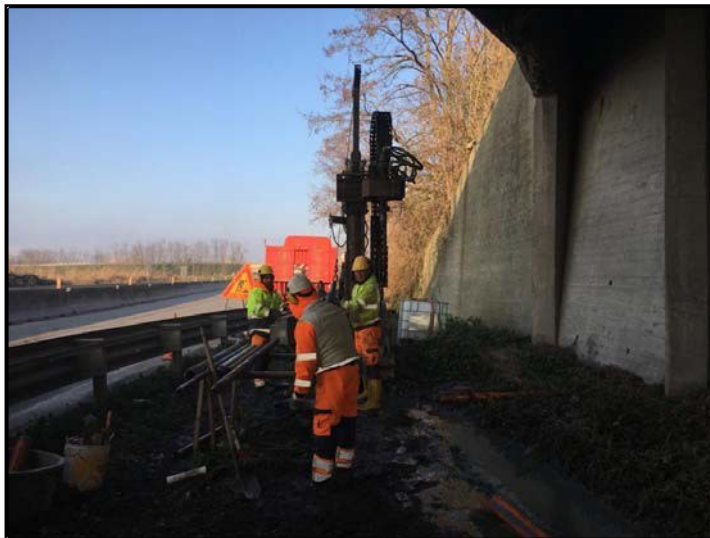
Foto n.18: Postazione sondaggio SN2
