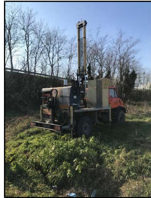
Foto n.45: Esecuzione prova CPTU11
