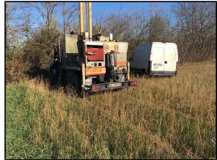
Foto n.38: Esecuzione prova CPTU4
