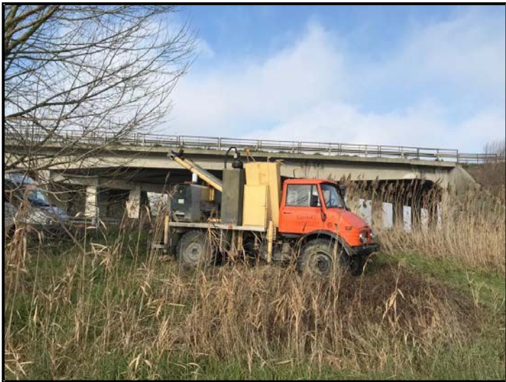
Foto n.44: Esecuzione prova CPTU10
