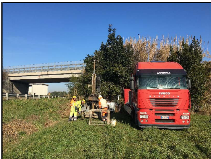
Foto n.1: Postazione sondaggio SN1
