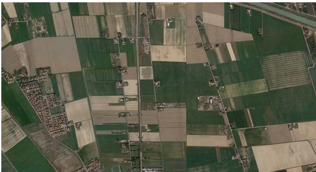
Figura 21 - Tratto stradale in riqualificazione su uso del suolo (Fonte RER, 2014) – zona Classe
