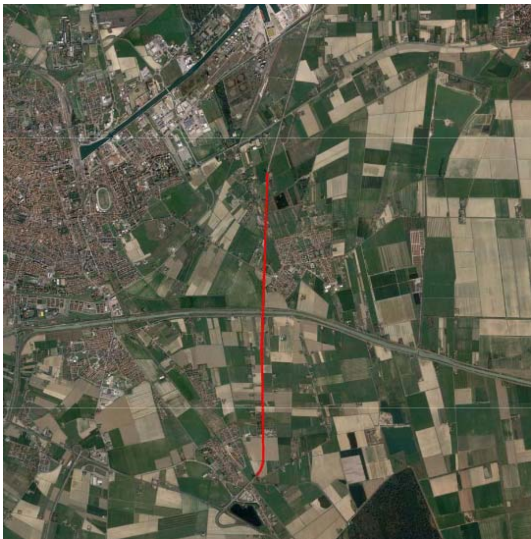
Figura 18 - Tratto stradale in riqualificazione su ortofoto (Google Earth)
