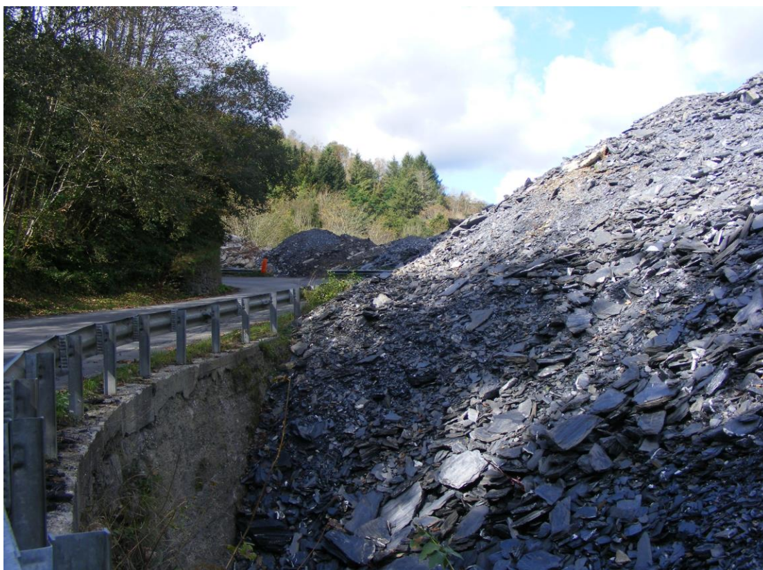
Area ove è prevista la realizzazione del Cantiere Base.
