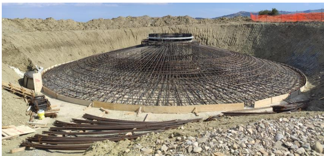
immagine tipo armature plinto
