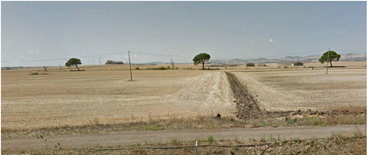
Vista in corrispondenza della turbina WGT 10
