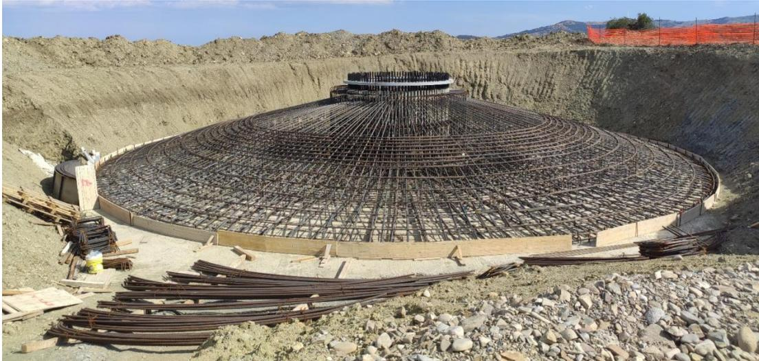
Figura 6\_immagine tipo armature plinto
