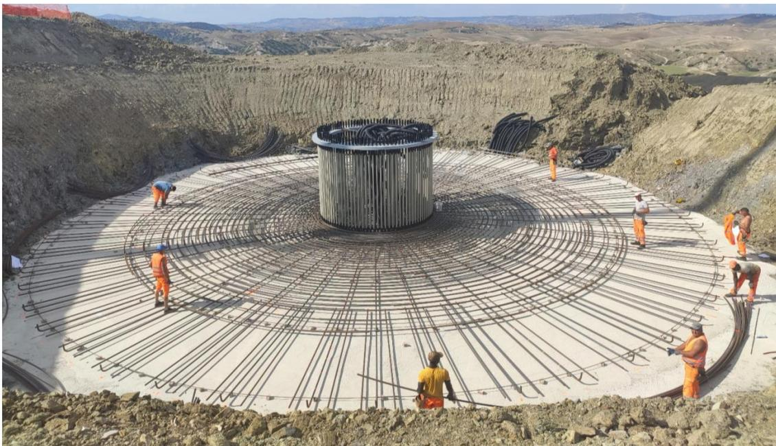
Figura 5\_immagine tipo posa anchor cages
