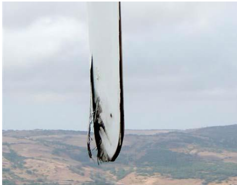
Figure 2_estremità di una pala danneggiata da fulminazione
