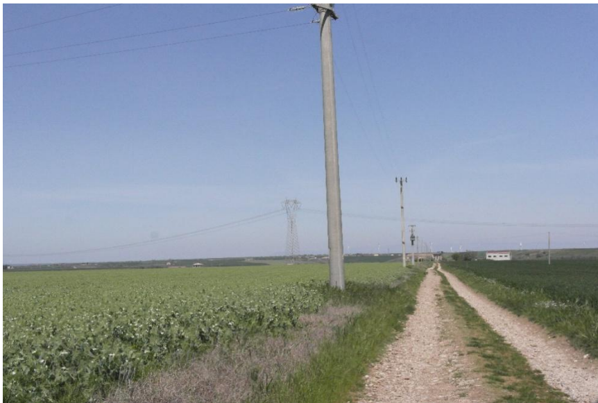
Foto 2: UR4, tratto cavidotto verso WTG10 su strada interpoderale, vista S-N, leguminose visibilità 2 a sinistra, cereali visibilità 2 a destra
