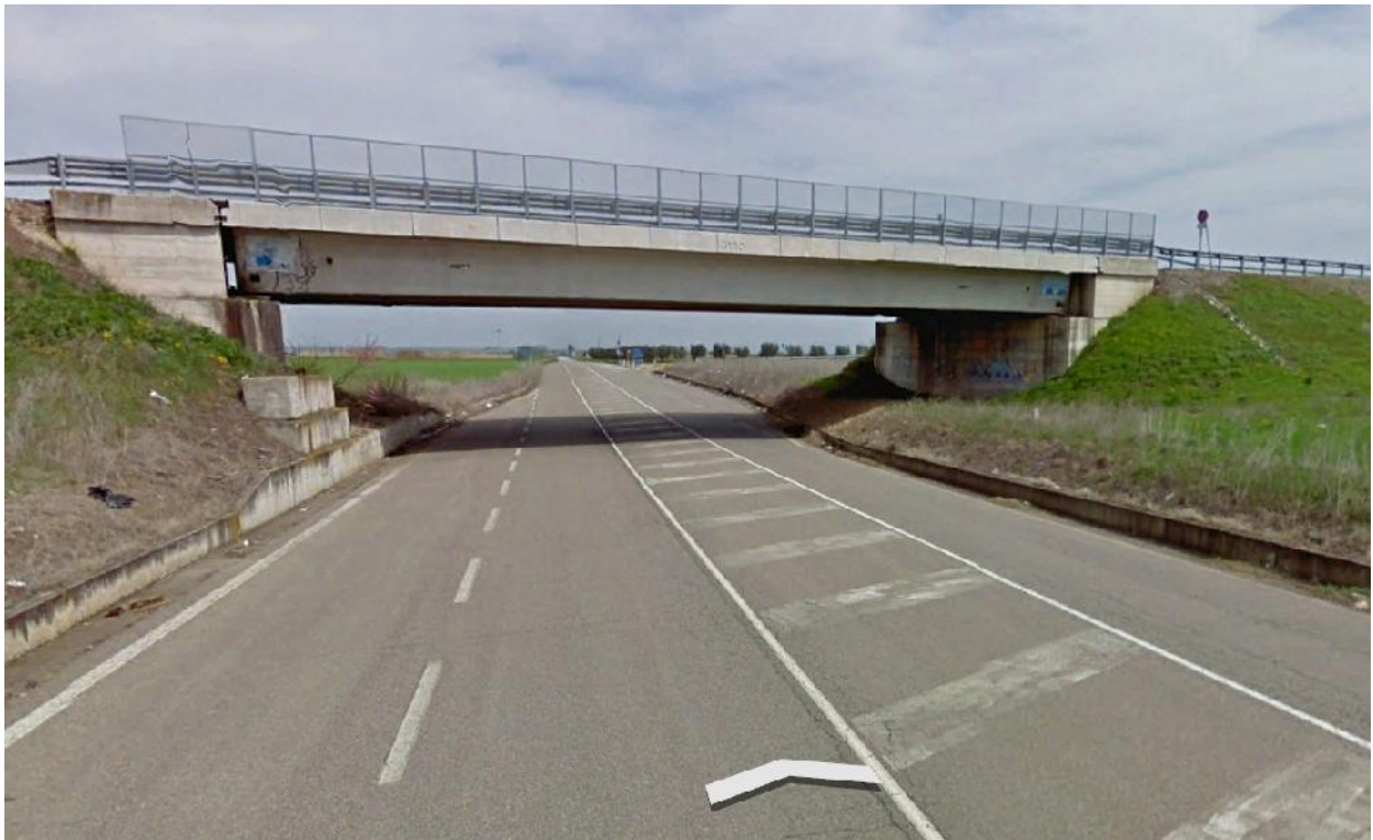
incrocio tra SS655 (ponte) e SP18 in prossimità dell'area di impianto
