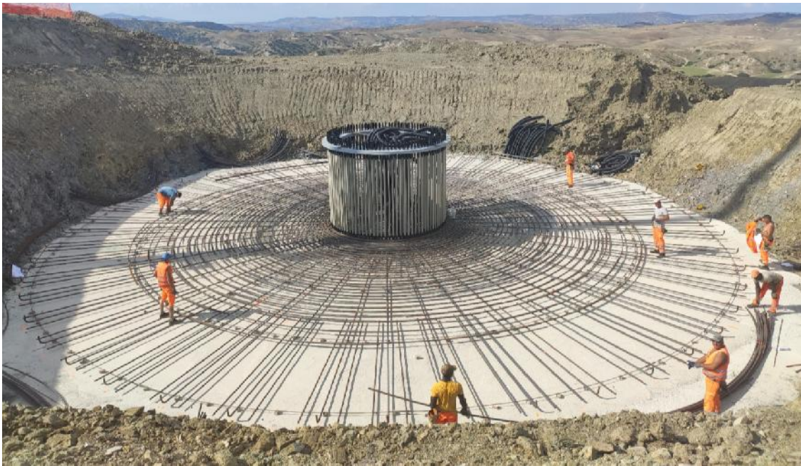
immagine tipo posa anchor cages
