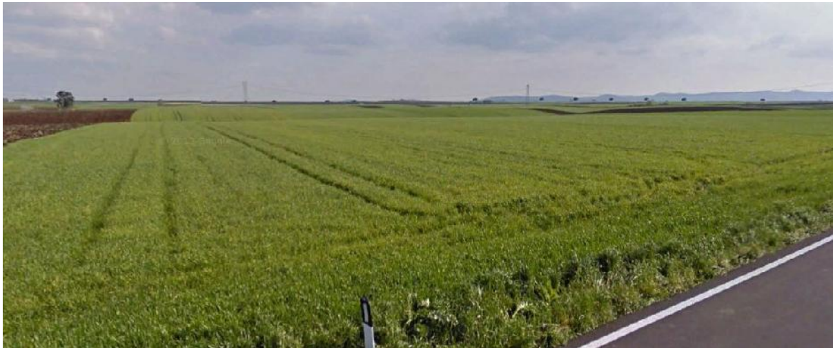
Vista in corrispondenza delle turbine WTG 4-5
