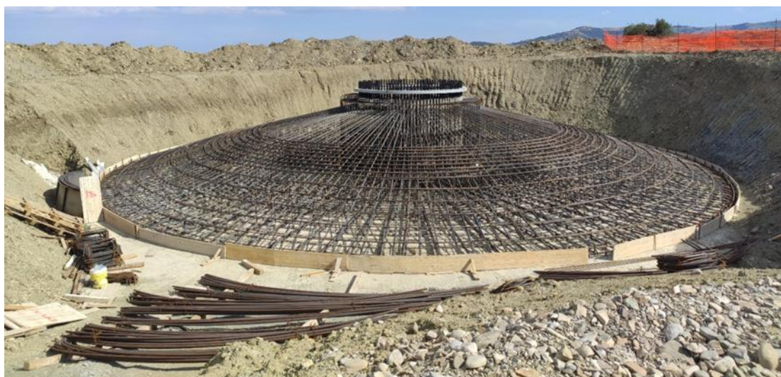
immagine tipo armature plinto
