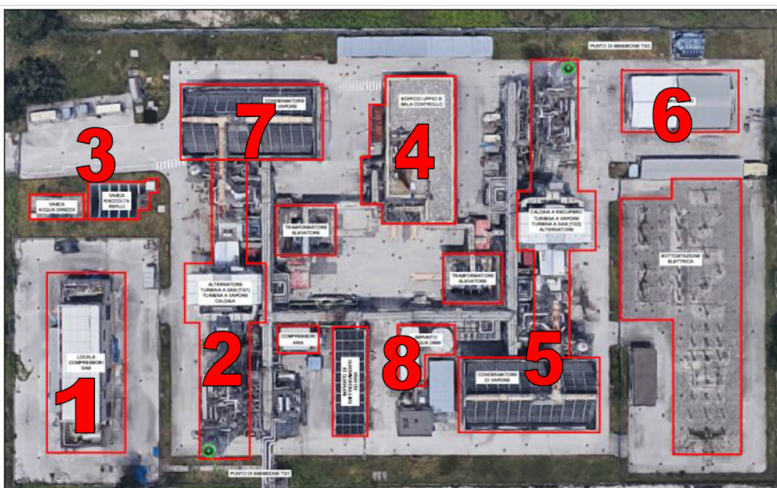
Figura 9 – Localizzazione ed area occupata dai lavori di demolizione e realizzazione dei nuovi impianti in fase di costruzione
