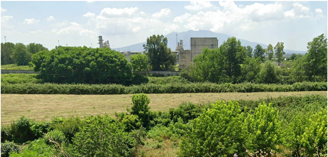
Figure 3-a e 3-b – Viste della centrale ENGIE dalla exSS162 e dalla SP Pomigliano-Acerra
