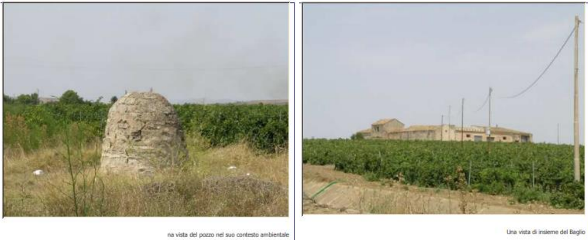
Figura 3.8: Pozzo Agropastorale (Sx) e Baglio La Favarotta (Dx) in prossimità della Centrale (Piano Paesaggistico Ambiti 2-3 – Schede dei Beni Isolati)
