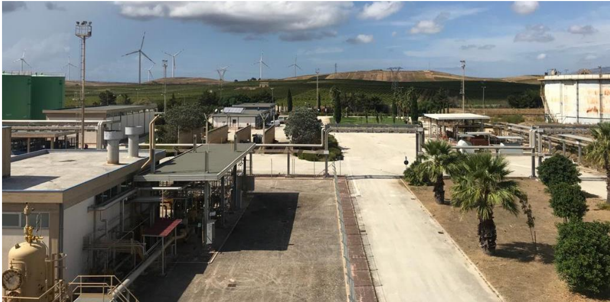
Figura 5.27: Parco Eolico a Nord-Nord-Ovest della Centrale e Paesaggio a Vocazione Agricola
