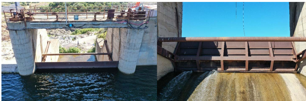
Fig. 4.5 : Scarico di alleggerimento - Vista da monte e da valle dello stato attuale
