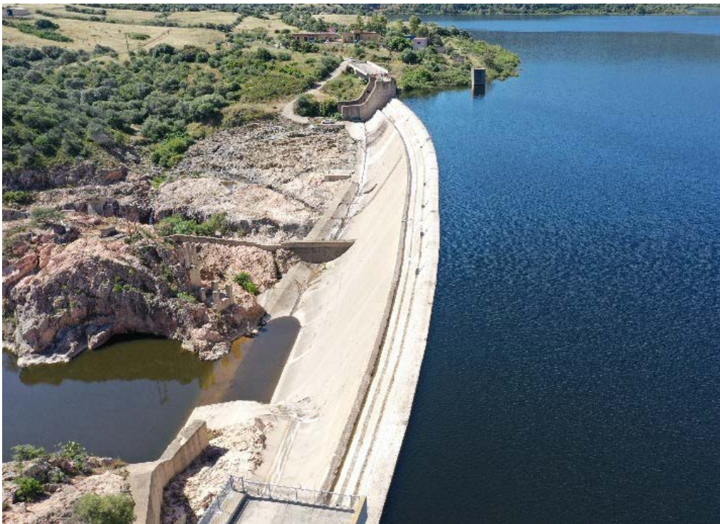
Fig. 4.3 : Vista dalla sponda sinistra, ex soglia sfiorante oggi demolita e sagomata a gradoni
