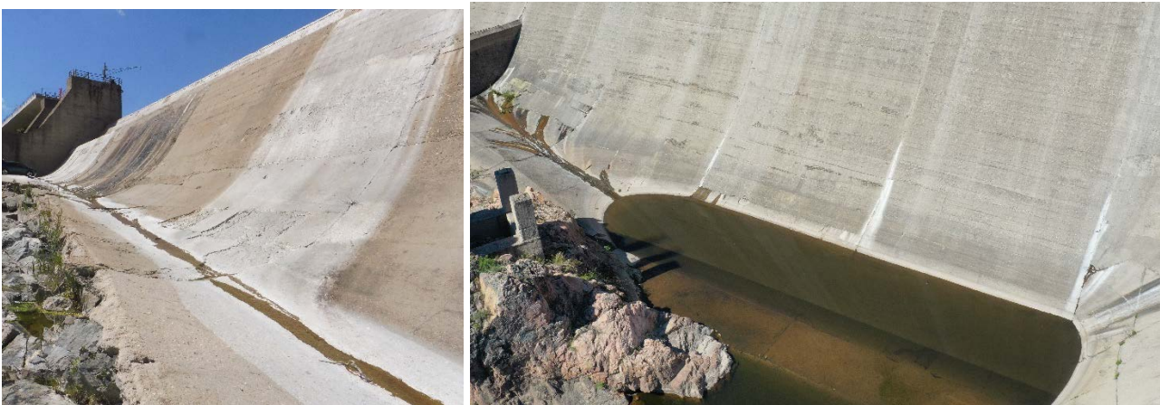
Fig. 4.18 : Fenomeni di efflorescenza sul paramento di valle (conci VII e XIV e XV)
