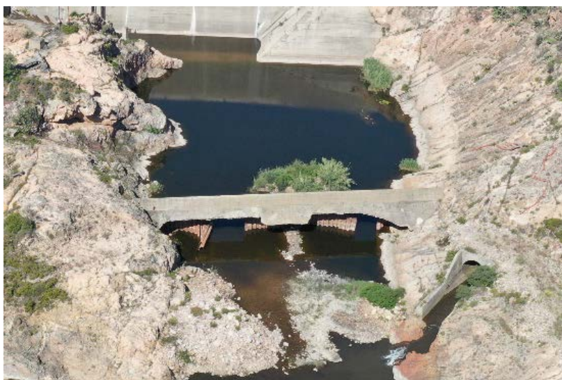
Fig. 4.11 : Retrodiga in alveo, a valle della diga ( foto SP, 2020 )
