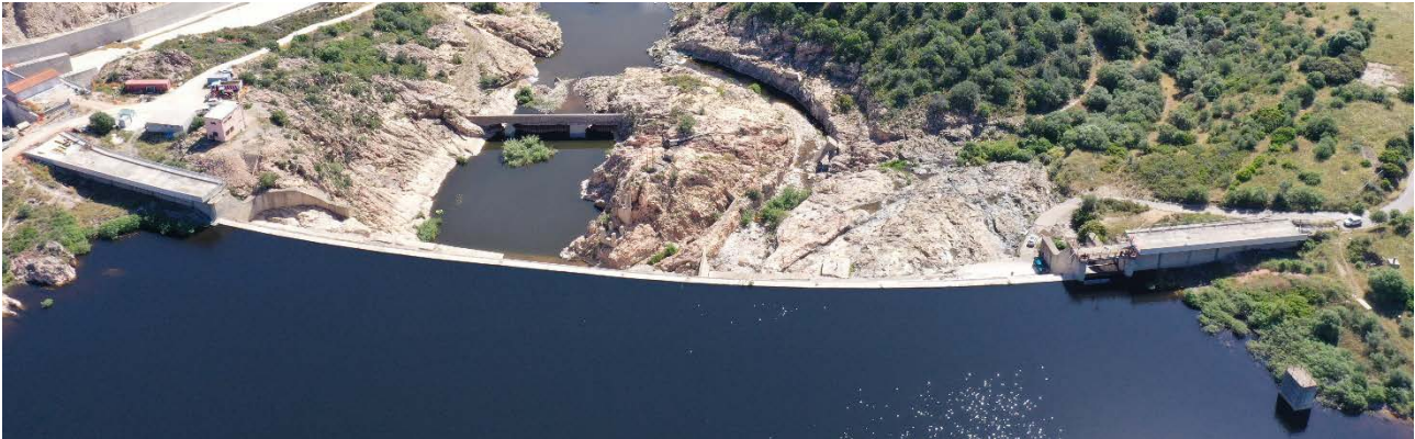
Fig. 4.2 : Vista dall'alto ( SP, maggio 2020, foto da drone )
