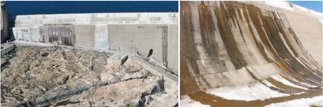
Fig. 4.17 : Filtrazioni visibili in sponda destra, conci VI, VII e X
