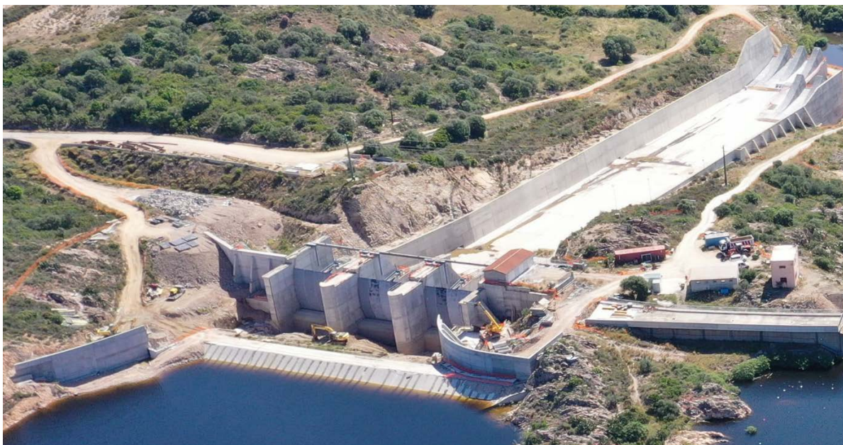
Fig. 4.6 : Scarico di superficie in sponda sinistra ( foto maggio 2020, SP )
