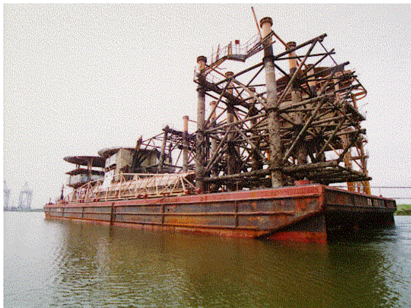
FIG 34 Trasporto delle Strutture Rimosse
