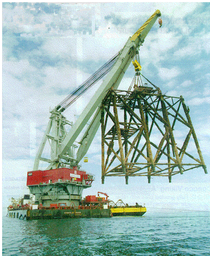
FIG 31 Sollevamento completo di un Jacket
