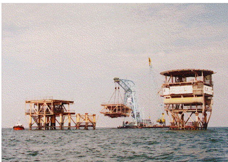
FIG 30 Sollevamento di un Deck
