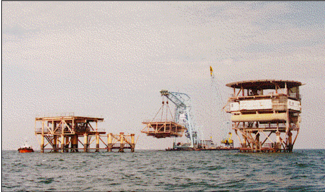
Figura 3-44: sollevamento di un deck
