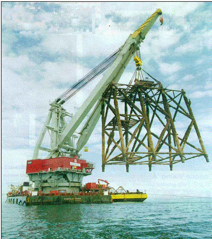
Figura 3-45: sollevamento completo di un jacket
