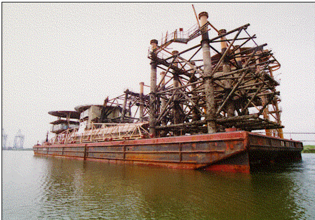
Figura 3-48: trasporto delle strutture rimosse
