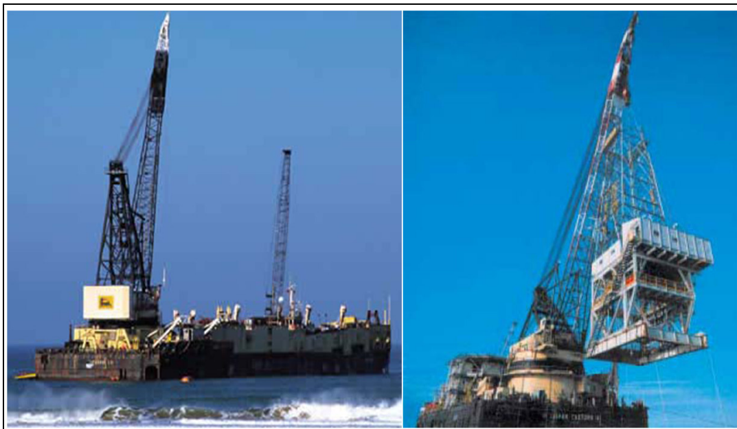
Figura 3-36: immagini del pontone di installazione della piattaforma (crane-barge)
