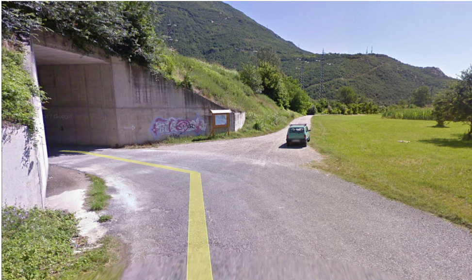
Foto 1: Viabilità di accesso all'area di cantiere
