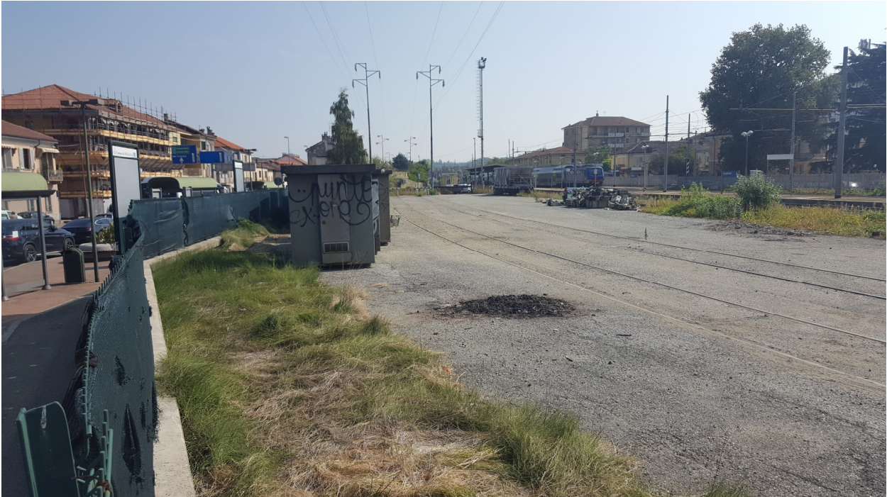
Foto 1: area di cantiere CA.01
