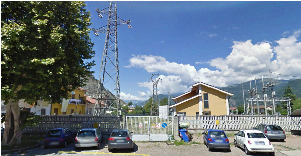
Accesso alla SSE da dimettere da piazza della Stazione
