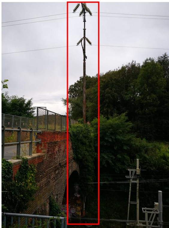
Figure 4-8 Esempio di palo aggrappato a struttura esistente
