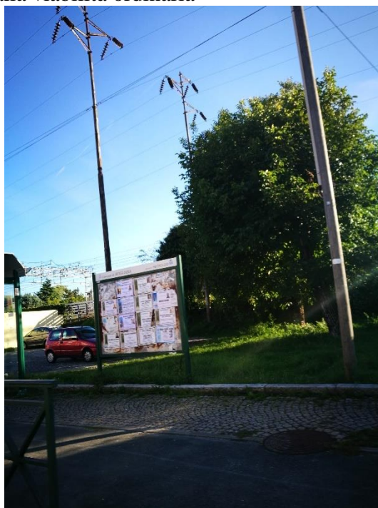
Figura 4-2 Esempio di palo adiacente alla viabilità ordinaria
