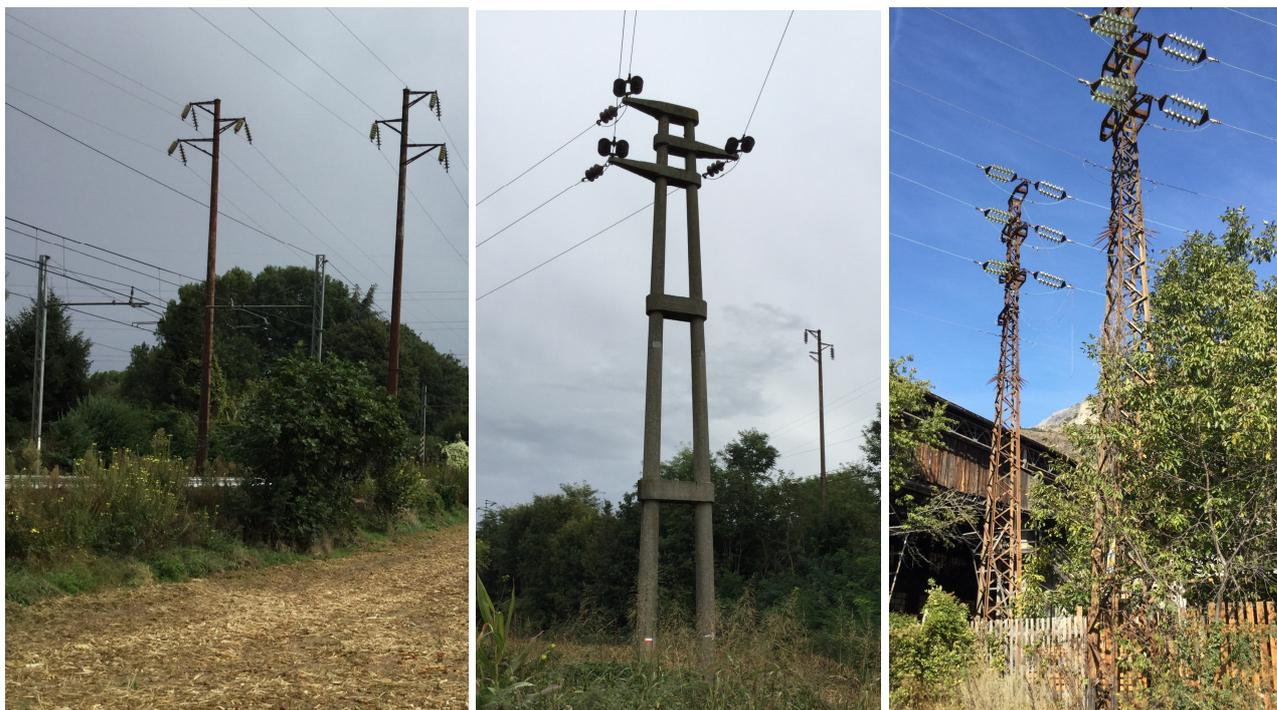
**Figura 4 Nell'ordine Pali Z9, M9 e tralicci metallici**
