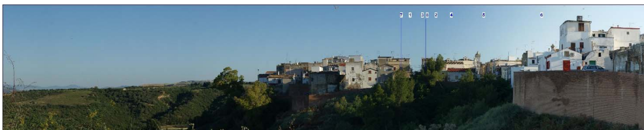
Figura 26: Stato dei luoghi post operam in corrispondenza del punto di ripresa fotografica A
