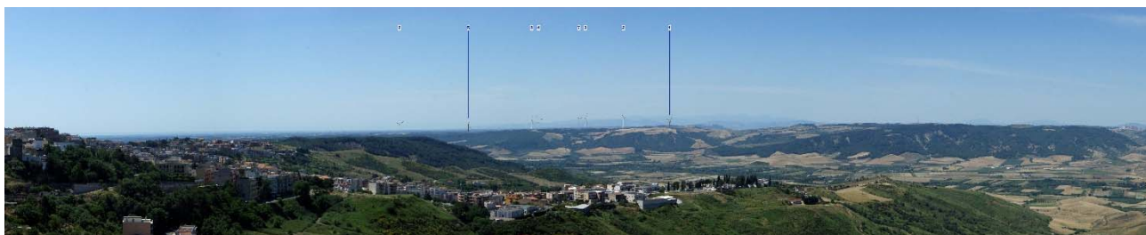
Figura 29 - Stato dei luoghi post operam in corrispondenza del punto di ripresa fotografica D
