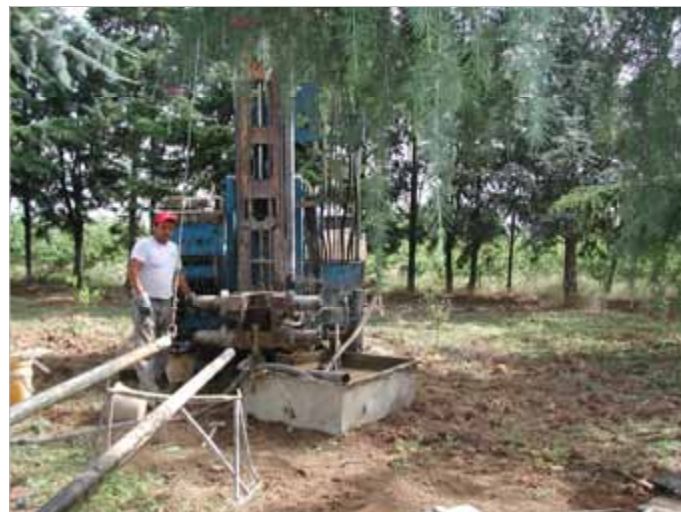
Foto: Postazione Sondaggio 1
