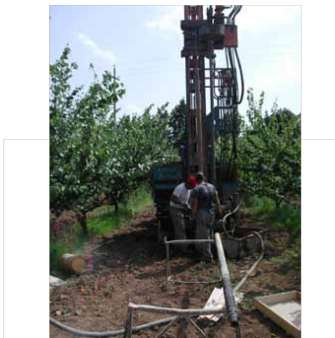
Foto: Postazione Sondaggio 1
