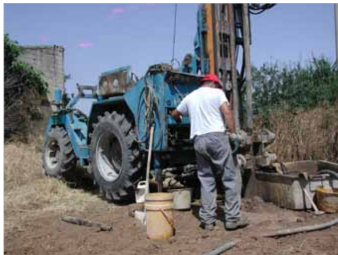
Foto: Postazione Sondaggio 1
