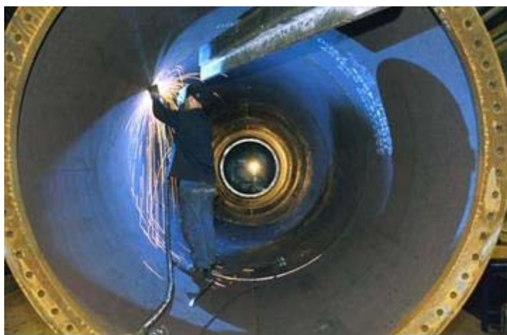
Figura 10: interno di una torre
