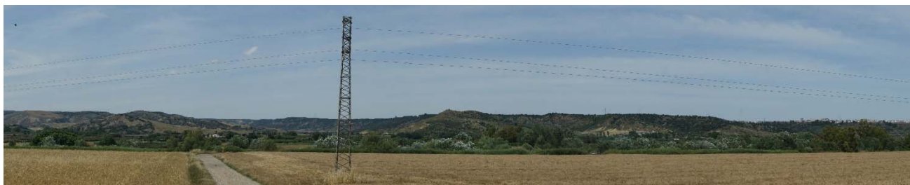
Figura 61: Stato dei luoghi in corrispondenza del punto di ripresa fotografica G (Pisticci – torre dell'Accio)
