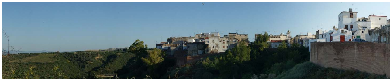
Figura 34: Stato dei luoghi in corrispondenza del punto di ripresa fotografica A
