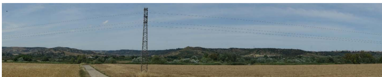
Figura 40: Stato dei luoghi in corrispondenza del punto di ripresa fotografica G
