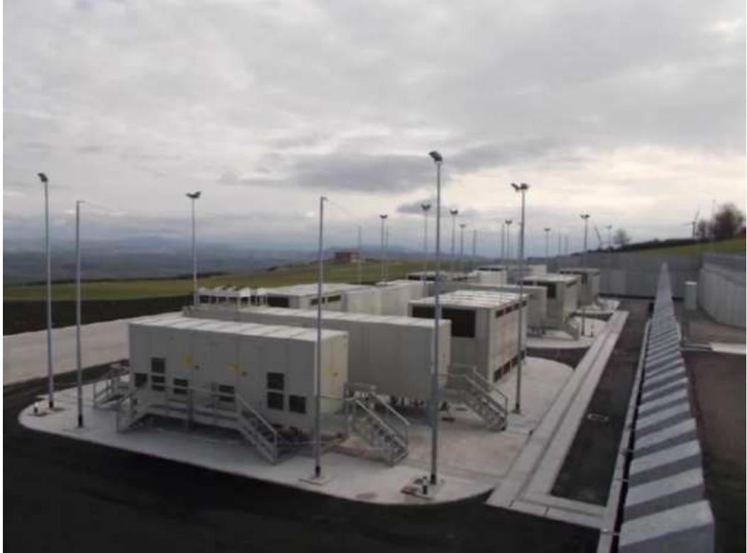
Il ruolo di un sistema di storage dell'energia è in genere quello di facilitare la gestione delle reti mediante il loro bilanciamento (set point di potenza attiva P) e il supporto alla regolazione di tensione.
