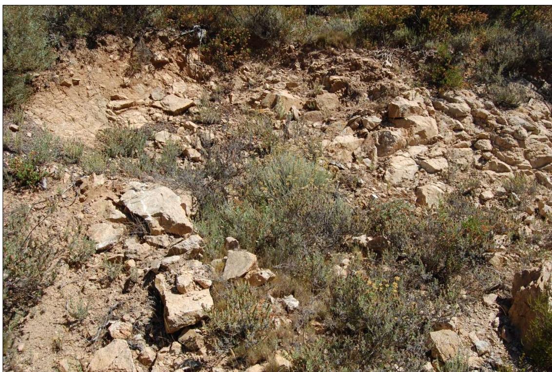
Fotografia 6. Sezione stradale lungo il previsto tracciato del cavidotto, in cui si osserva roccia di consistenza da sub-litoide a litoide immediatamente al di sotto di una debole copertura eluvio-colluviale.
