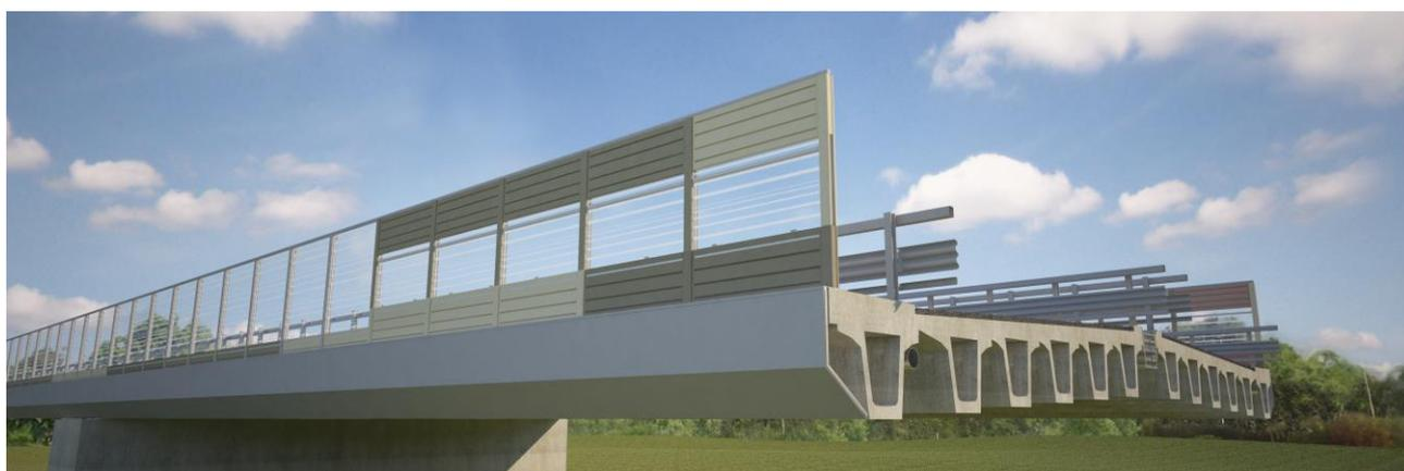
**FIGURA 4-30 – SOLUZIONE ARCHITETTONICA VIADOTTO CON IMPALCATO IN CAP**
