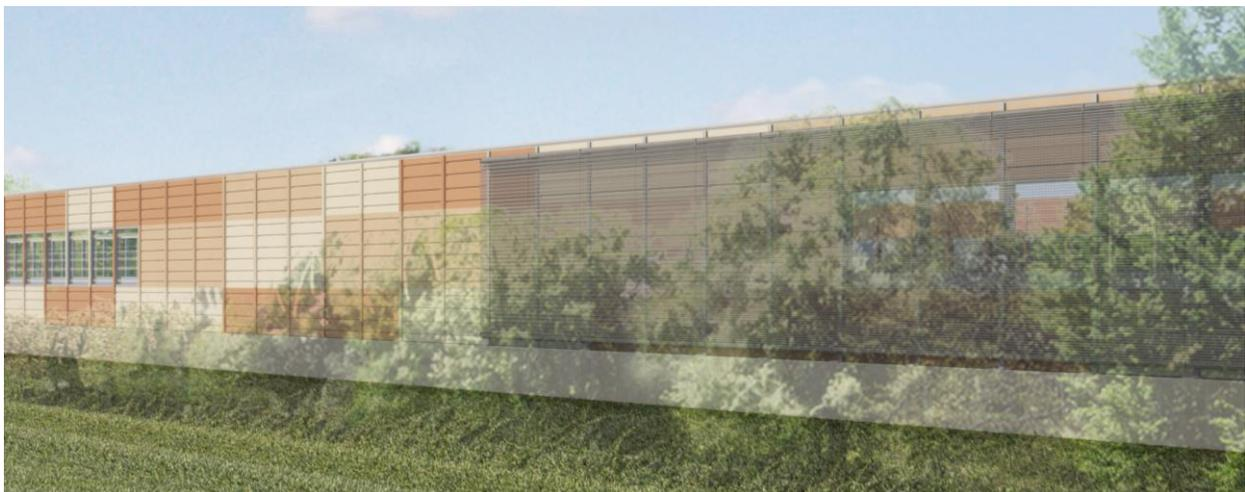
FIGURA 5-3 - BARRIERA ACUSTICA OPACA FONOASSORBENTE SU RILEVATO – VISTA LATO RICETTORE
