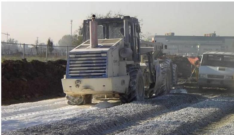
**FIGURA 4-41 – STABILIZZAZIONE DELLE TERRE – MISCELAZIONE MEDIANTE PULVIMIXER.**
