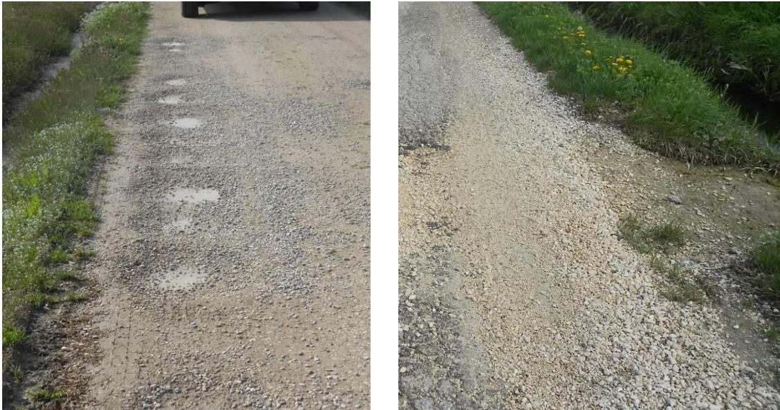
**FIGURA 4-34– A) PRESENZA DI BUCHE RISCONTRATORE NEL CORSO DEL SOPRALLUOGO PRELIMINARE; B) FORTE PENDENZA DEGLI STRADELLI IN DIREZIONE DEI FOSSI LATERALI**
