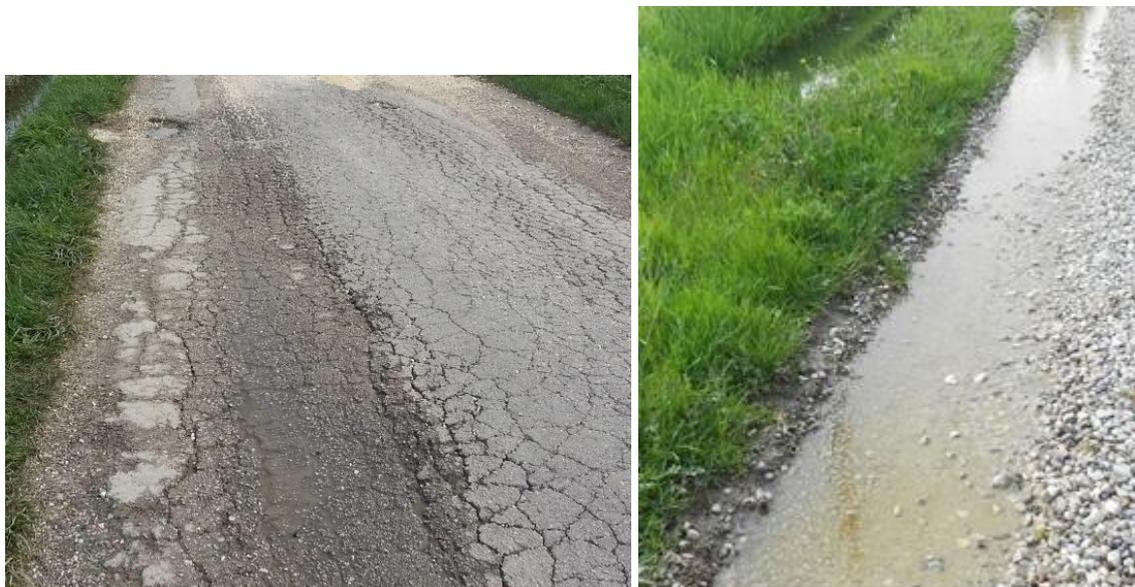
**FIGURA 4-35 – A) FESSURAZIONI ALL'INTERNO DELLO STRATO DI USURA; B) PRESENZA DI ACQUA AI LATI DEGLI STRADELLI**
