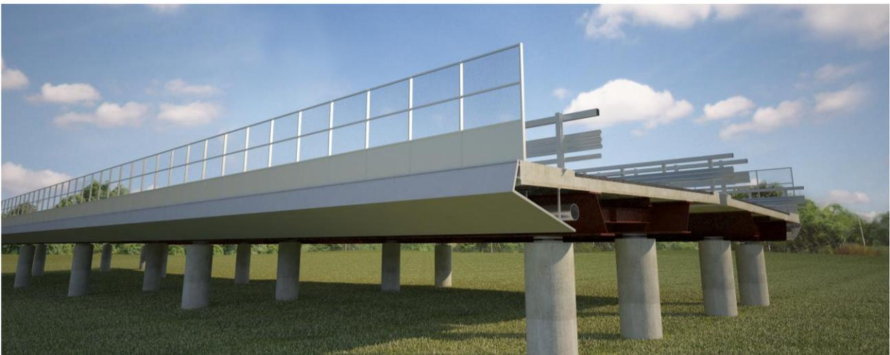
**FIGURA 4-31 – SOLUZIONE ARCHITETTONICA VIADOTTO CON IMPALCATO METALLICO A SEZIONE RIBASSATA**
