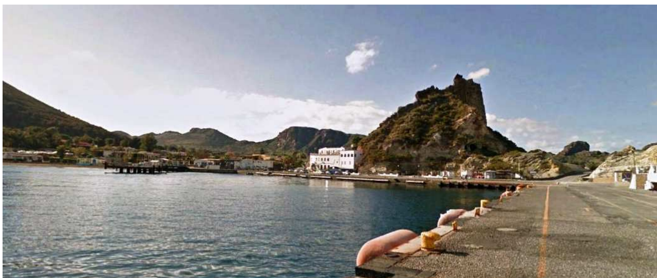
Figura 8. Vulcano. Area di intervento. Panoramica. Vista da nord/est.
