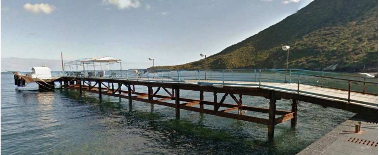
Figura 9. Vulcano. Area di intervento. Pontile metallico. Dettaglio.
