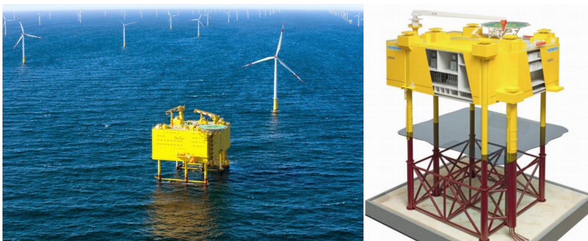
Figura 18 - stazione HVDC di trasformazione e conversione 66/500 kV AC/DC
