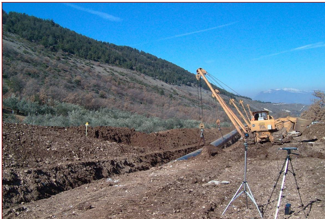
Fig. 6.1/A: Rilievi acustici durante l'operazione di posa della condotta.
