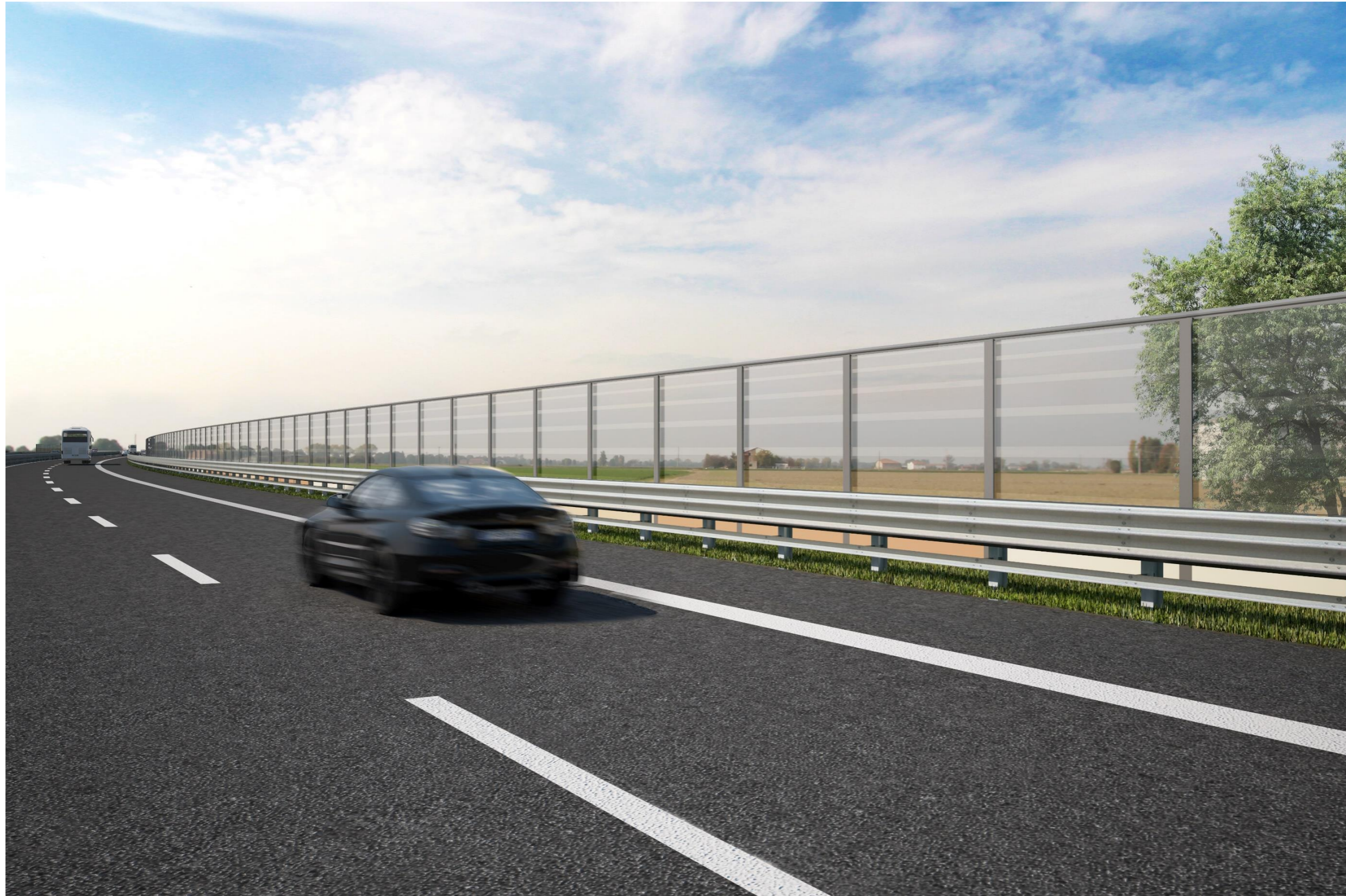
FIGURA 3-21 SIMULAZIONE FOTOGRAFICA N.1 DELLA PERCEZIONE DI VIAGGIO DALL'INFRASTRUTTURA CON LA BARRIERA ABA05INT NELLA VERSIONE TRASPARENTE
