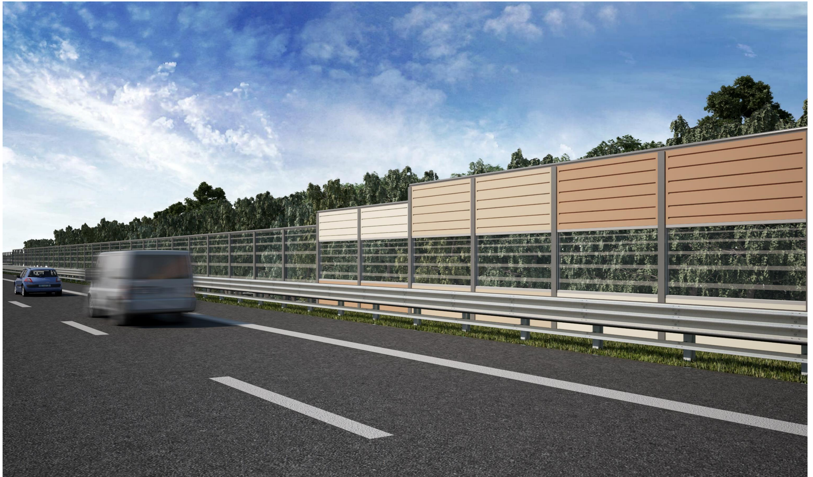
FIGURA 3-23 SIMULAZIONE FOTOGRAFICA N.2 DELLA PERCEZIONE DEL TRATTO DI TRANSIZIONE CON LA BARRIERA ABA05INT NELLA VERSIONE TRASPARENTE
