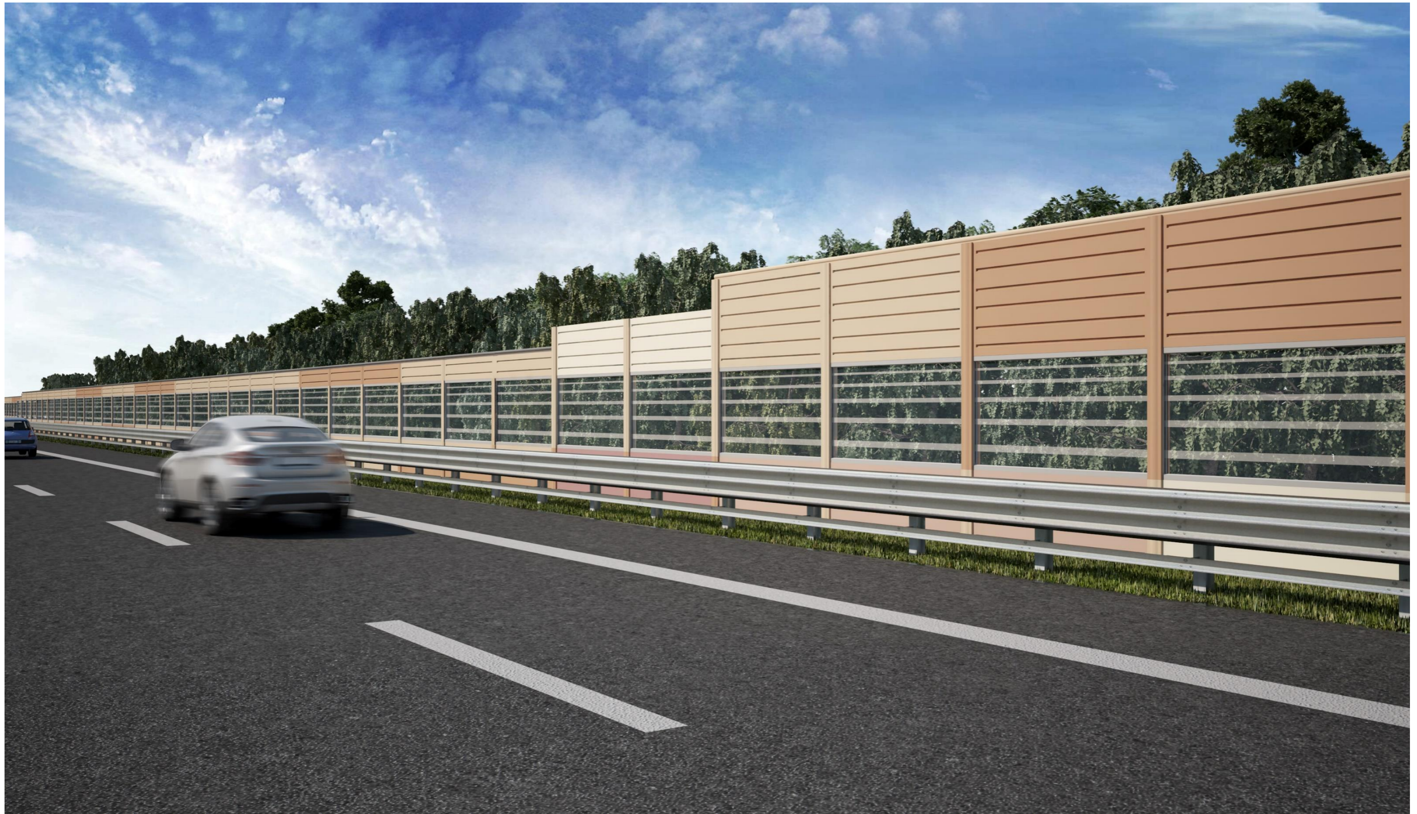
FIGURA 3-22 SIMULAZIONE FOTOGRAFICA N.2 DELLA PERCEZIONE DEL TRATTO DI TRANSIZIONE CON LA BARRIERA ABA05INT NELLA VERSIONE MISTA
