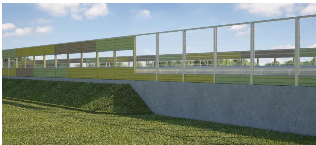
FIGURA 7-14 –TRATTO DI TRANSIZIONE RILEVATO-MURO DI SOSTEGNO
