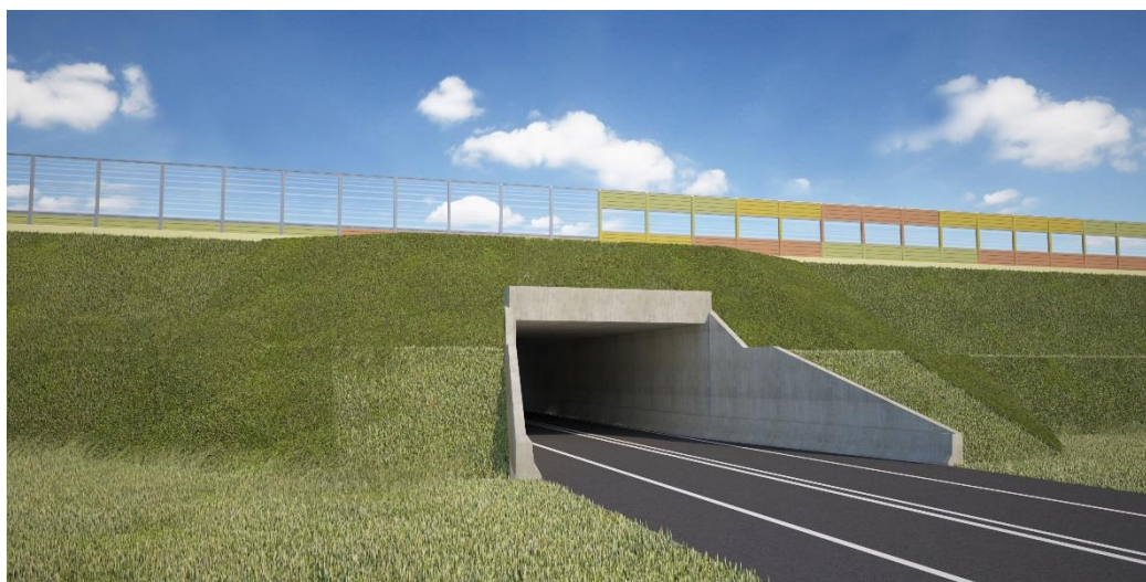
FIGURA 7-15 –TRATTO DI TRANSIZIONE RILEVATO-SOTTOVIA
