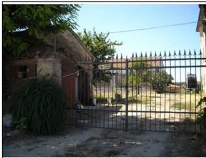
Vista da: Nord Est
