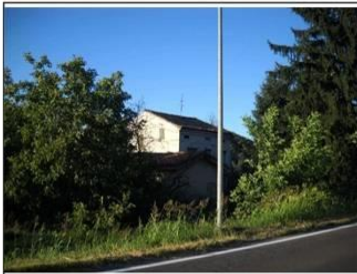
Vista da: Ovest
